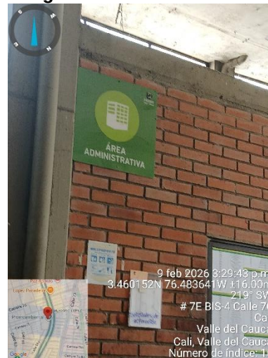
Foto 13. Ingreso a oficinas administrativas.
