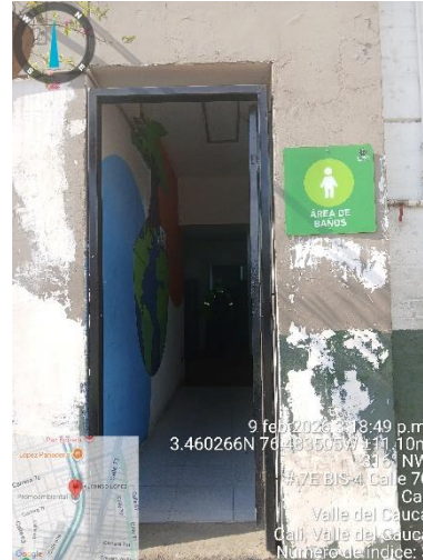
Foto 12. Área de baños
