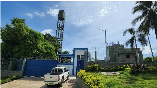
Imagen 4 Encerramiento perimetral PTAP's
