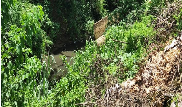
Imagen 24 Remante de aguas combinadas
