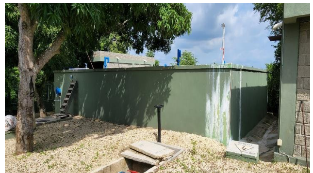
Imagen 15 Tanque No. 2 (nuevo)
