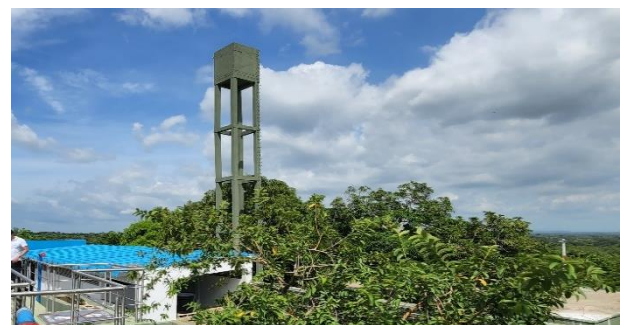
Imagen 13 Tanque de lavado de filtros
