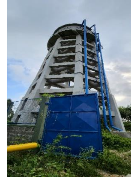
Imagen 17 Tanque elevado (fuera de operación)
