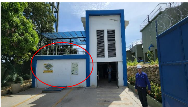
Imagen 14 Tanque No. 1 (antiguo)
