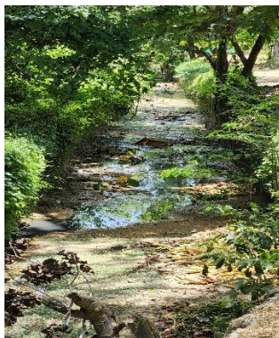
Imagen 22 Canal abierto en concreto
