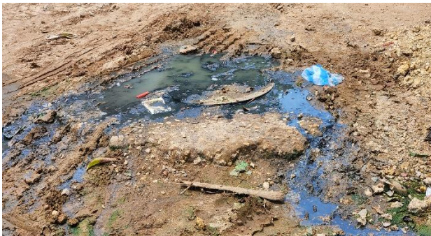
Imagen 20 Punto de alcantarillado sanitario
