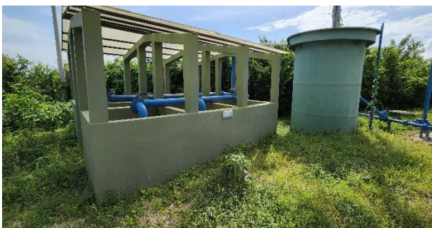
Imagen 12 Lecho de secado de lodos
