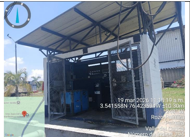
Fotografía 59. Equipo de pesaje para básculas de entrada y salida
