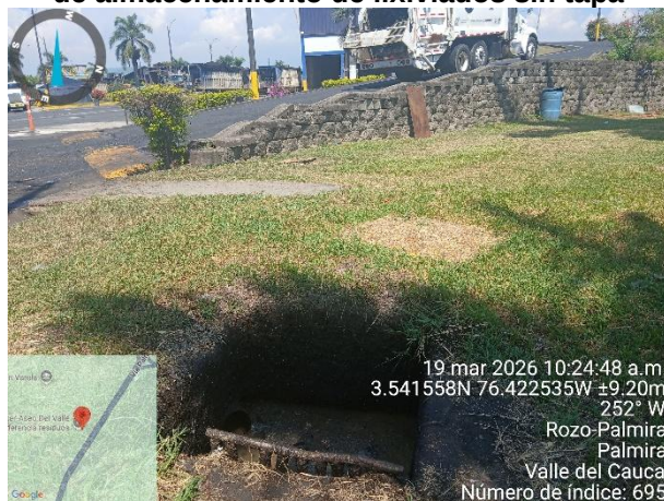
Fotografía 54. Rejillas faltantes en canales recolectores de lixiviados
