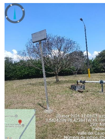
Fotografía 63. Caja de transferencia de residuos cargada y con goteo de lixiviados
