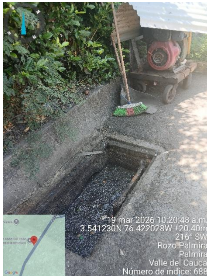
Fotografía 52. Caja de inspección de tanques de almacenamiento de lixiviados sin tapa
