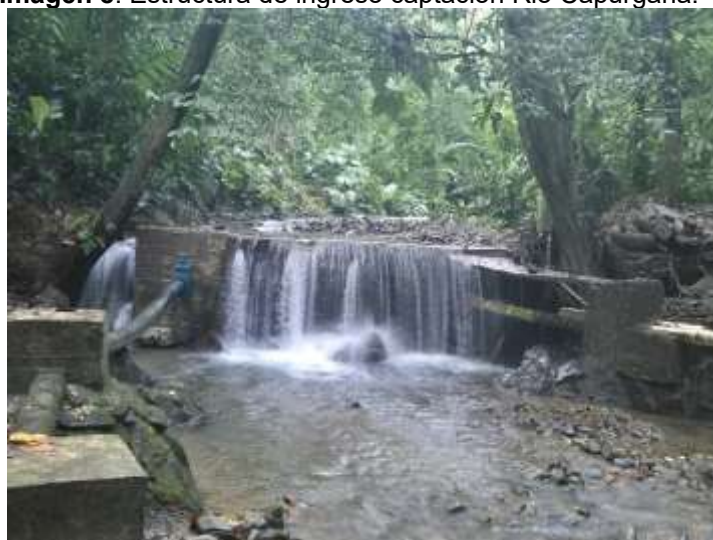
Imagen 8. Estructura de ingreso captación Río Capurganá.
