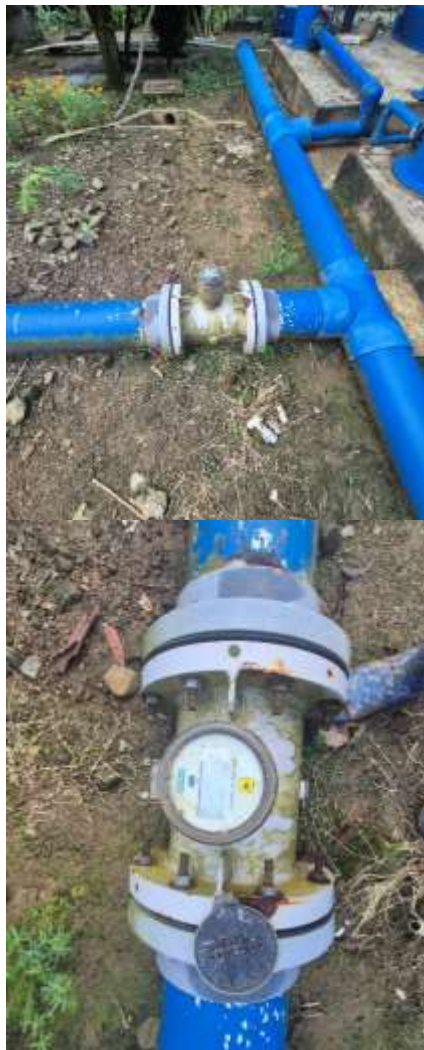
Equipos de medición a la entrada y salida de la PTAP Fuente: Registro fotográfico de la visita SSPD, mayo de 2026.
