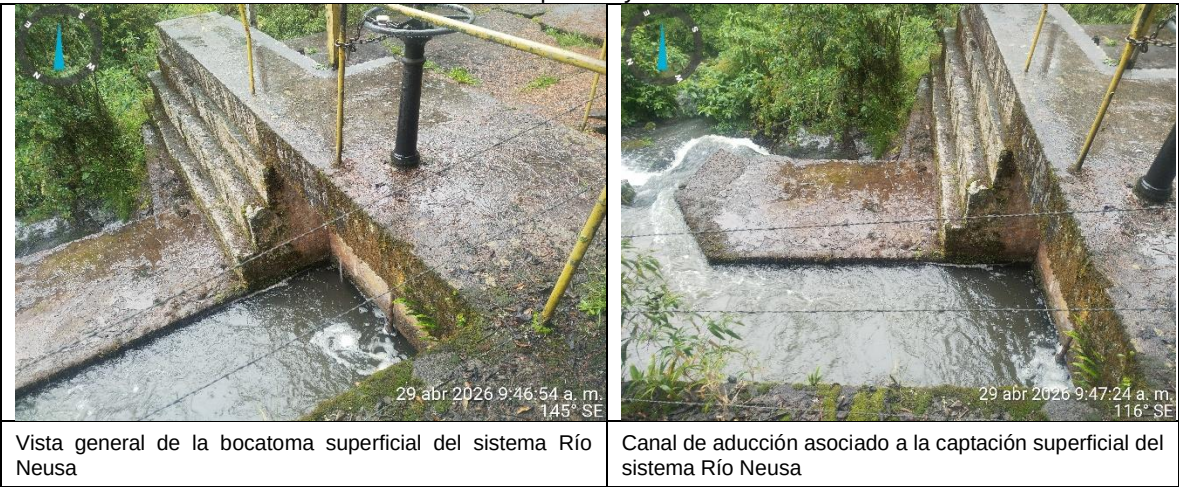
Imagen 7. Registro fotográfico de la bocatoma superficial del sistema Río Neusa y estructuras asociadas de captación y aducción.
