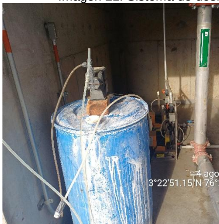
Imagen 21. Sistema de dosificación de productos químicos PTAP Arenal
