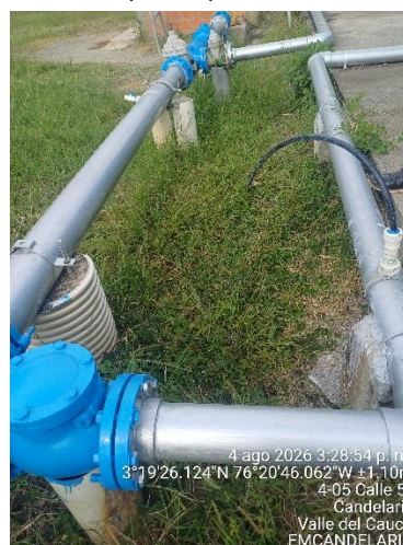
Tubería de aducción
