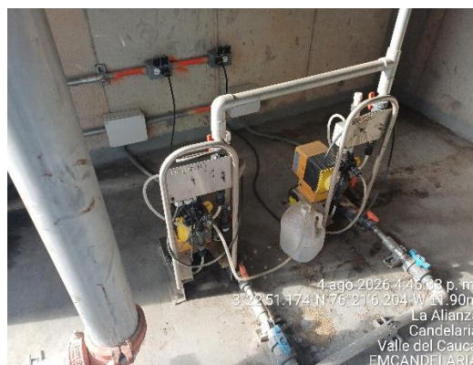
Imagen 21. Sistema de dosificación de productos químicos PTAP Arenal
