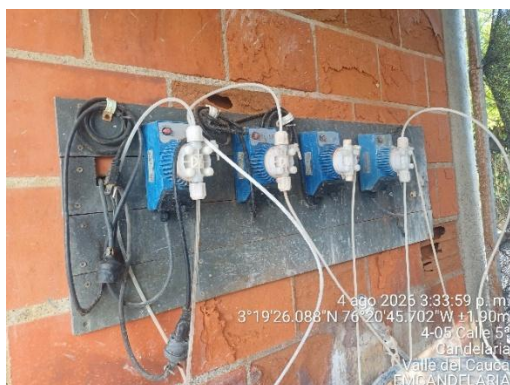
Imagen 12. Sistema de dosificación de productos químicos – PTAP El Cabuyal
