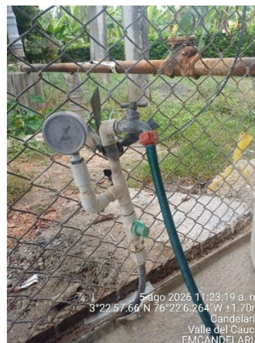
Punto de muestreo y manómetro
