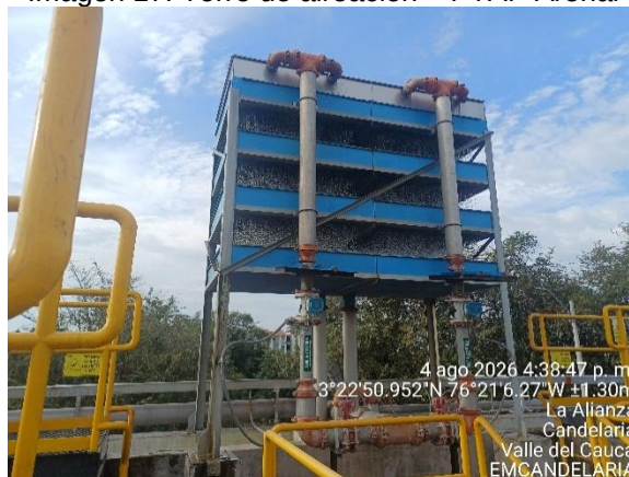
Imagen 17. Torre de aireación – PTAP Arenal
