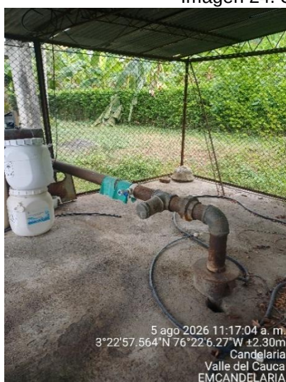
Pozo de captación de aguas subterráneas
