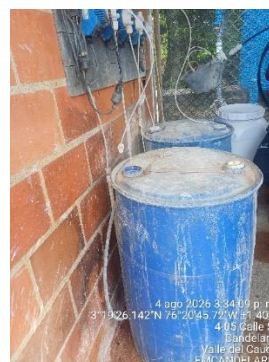
Imagen 12. Sistema de dosificación de productos químicos – PTAP El Cabuyal
