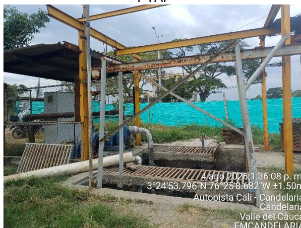
Imagen 33. Predio donde se encontraba el sistema lagunar anterior, actualmente en construcción de nueva PTAP
