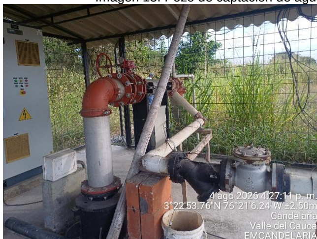
Imagen 15. Pozo de captación de aguas subterráneas – PTAP Arenal
