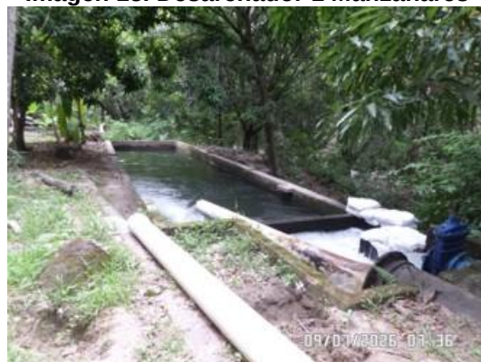
Imagen 13. Desarenador 1 Manzanares
