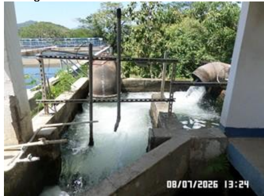
Imagen 16. Estructura de entrada Planta 2
