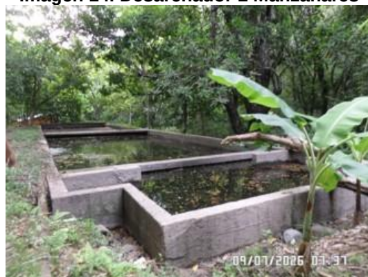
Imagen 14. Desarenador 2 Manzanares
