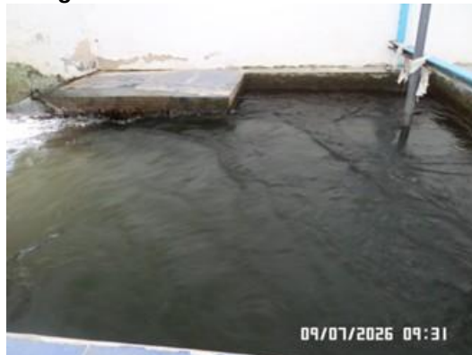
Imagen 25. Estructura de entrada Planta
