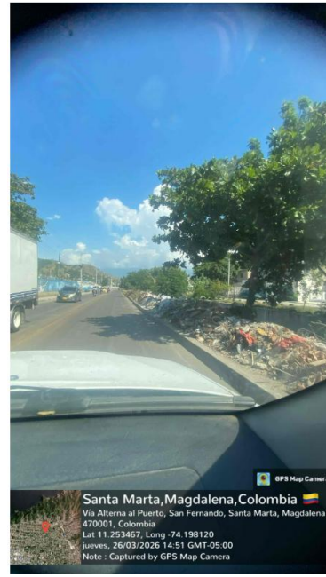
Foto 62 Punto crítico Vía alterna
