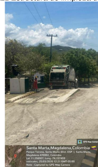
Foto 121 Estructura de limpieza de ruedas
