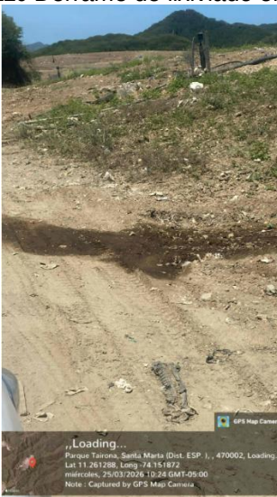
Foto 120 Derrame de lixiviado en la vía
