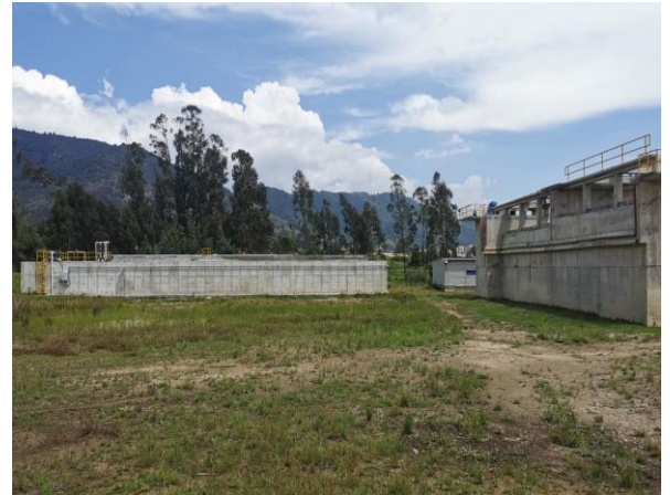
Tanque de contacto de cloro y Reactores
