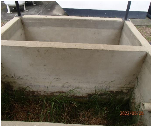
Imagen 17. Celda de secado de lodos
