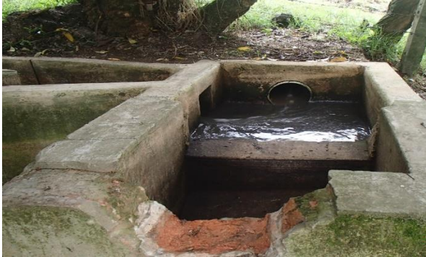
Imagen 13. Desarenador y sistema de alivio
