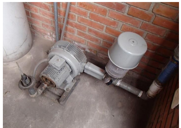
Imagen 34. Bomba de aireación
