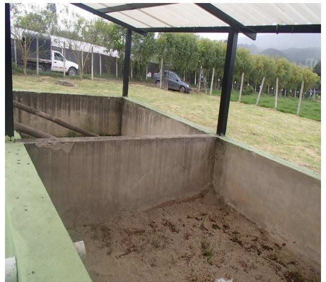
Imagen 22. Lecho de secado de lodos
