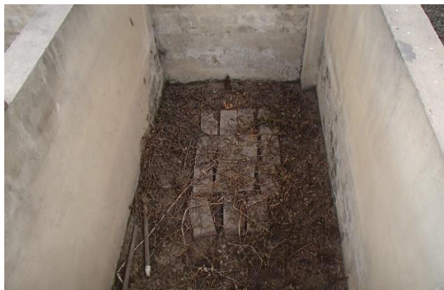
Imagen 37. Celda de secado de lodos
