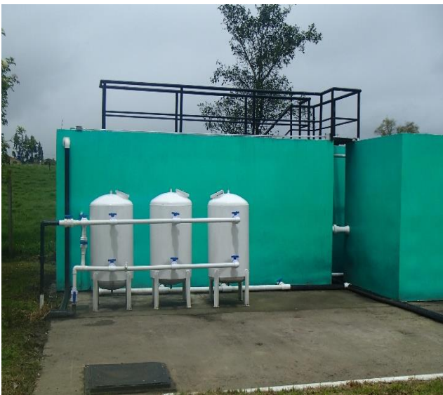
Imagen 21. Reactor aerobio
