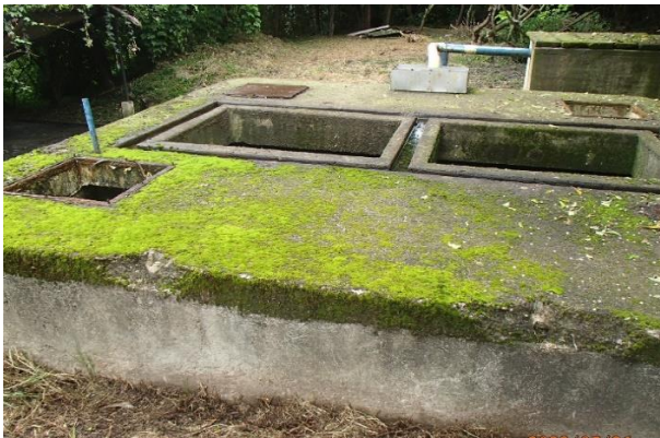
Imagen 13. Desarenador y sistema de alivio
