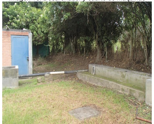
Imagen 16. Desarenador y cuarto de maquinas
