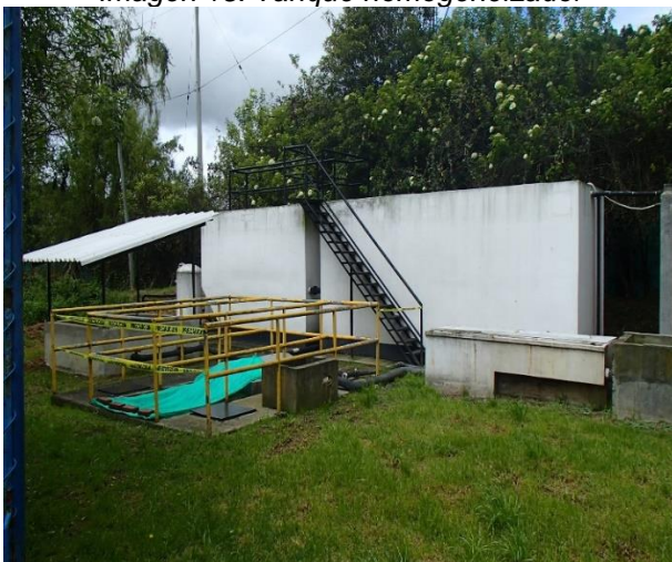
Imagen 15. Tanque homogeneizador
