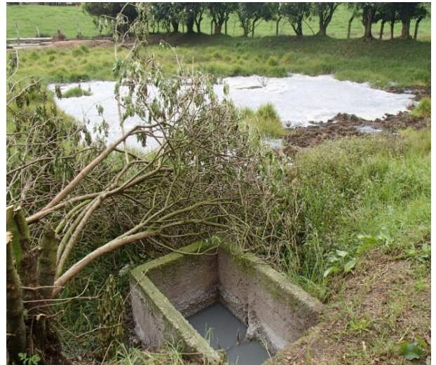
Imagen 46. Cámara de paso a descarga
