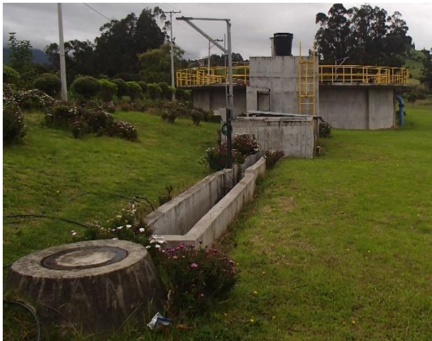
Imagen 1. Canaleta parshall y estación principal de bombeo
