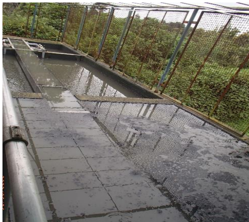
Imagen 5. Tanque de aquietamiento y sedimentador
