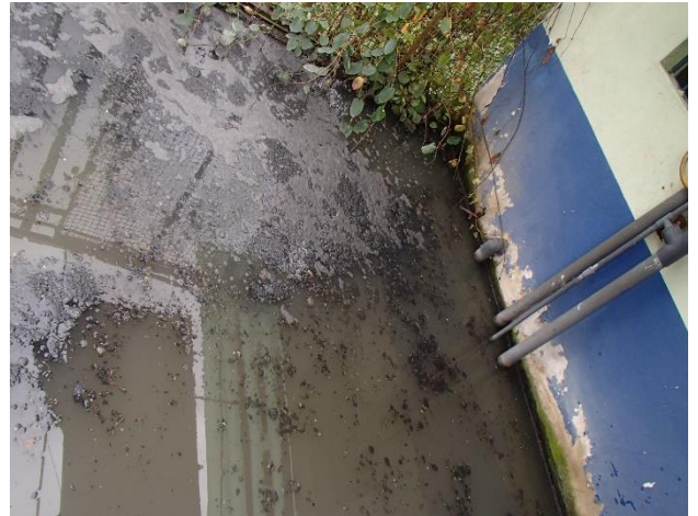
Imagen 8. Tanque colmatado
