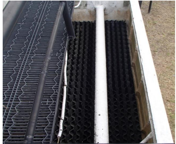
Imagen 32. Sedimentador colmena
