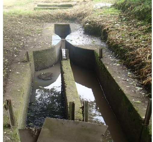
Imagen 22. Lecho de secado de lodos
