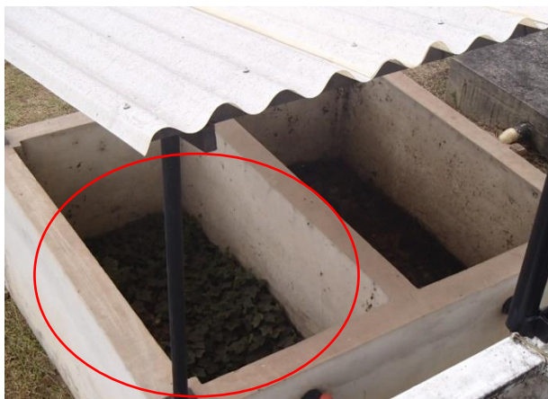
Imagen 33. Celda de secado de lodos
