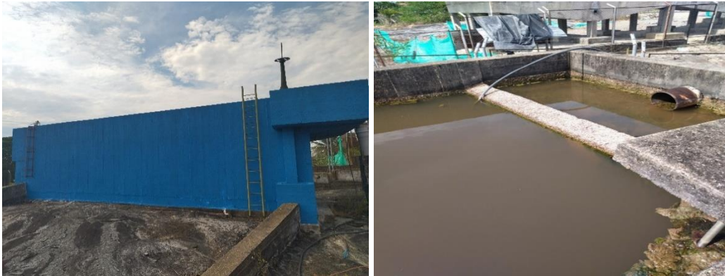
Imagen 6. Desarenador
