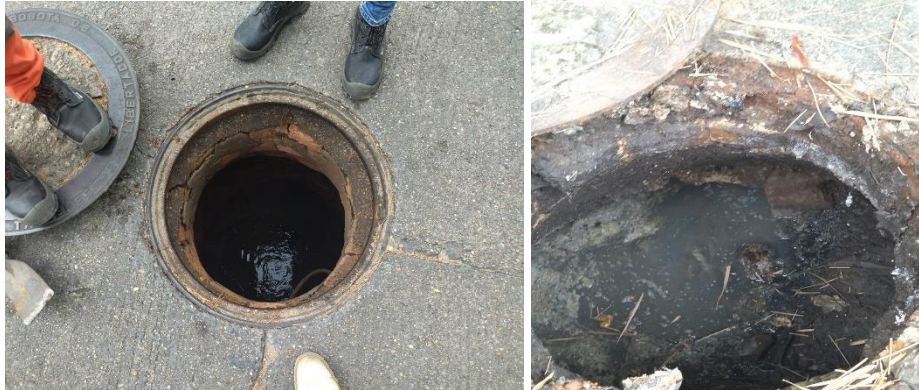
Imagen 17. Pozos de Inspección
