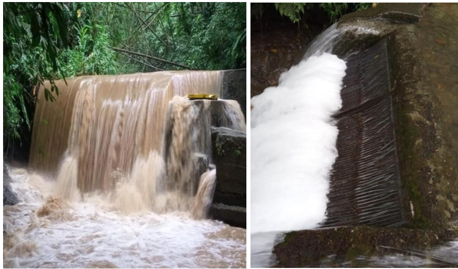
Imagen 6. Bocatoma Chapinero – Quebrada Buenavista
