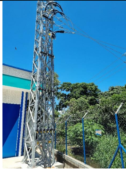
Cables de salida circuito – subestación interior – UC N3S62 – 3 UNIDADES
