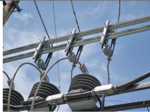
Seccionador monopolar N2 – UC N2EQ24 – 3 UNIDADES
