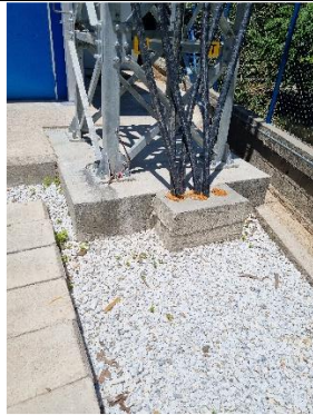
Transición aérea – subterránea – N3 – UC N3EQ9 – 2 UNIDADES
