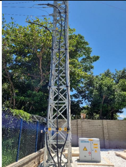
Cables de salida circuito – subestación interior – UC N3S62 – 3 UNIDADES
