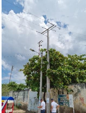
11°00'44.2"N 74°14'33.4"W Fin tramo 2 en cable AAC 123, 520 metros
