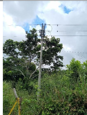
11°14'29.9"N 73°30'43.6"W Estructura terminal tramo de tendido 1270 metros
