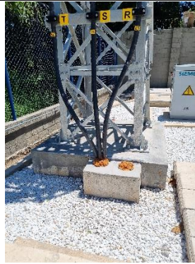
Transición aérea – subterránea – N3 – UC N3EQ9 – 2 UNIDADES
