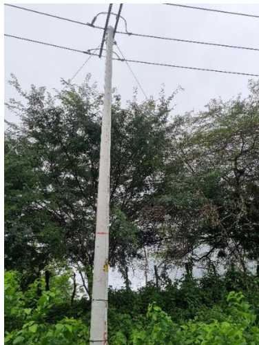
10°47'18.5"N 75°06'31.6"W, Estructura de arranque, poste 12x1324 Kg, cable CF159
