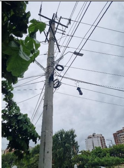
11°00'19.4"N 74°50'04.6"W Estructura intermedia
