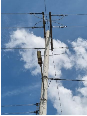
11°00'39.8"N 74°14'40.1"W Fin tramo 1 cable 4/0, 270 metros
