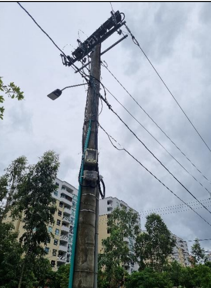
11°01'01.4"N 74°51'15.3"W Inicio tendido conductor AAC 394,5
