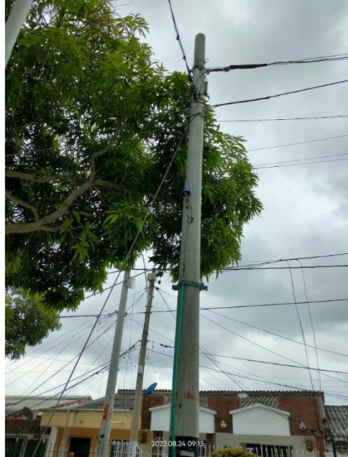
10°57'50.2"N 74°47'56.3"W AOE infraestructura de tercero retenida AP aparentemente energizada Fuente: SSPD visita en campo
