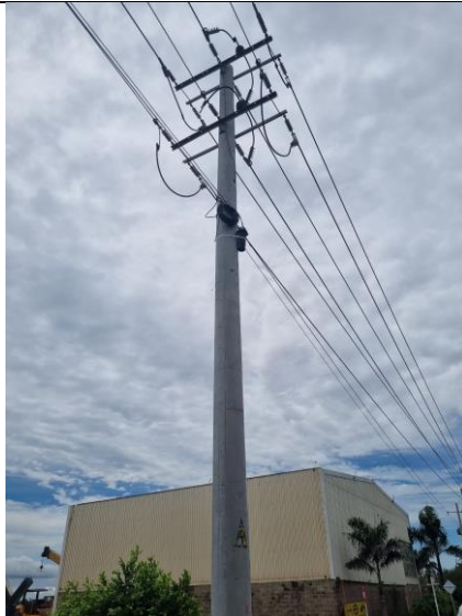
10°58'14.8"N 74°45'35.7"W, Estructura final tramo cable 266 semiaislado, 330 metros.
