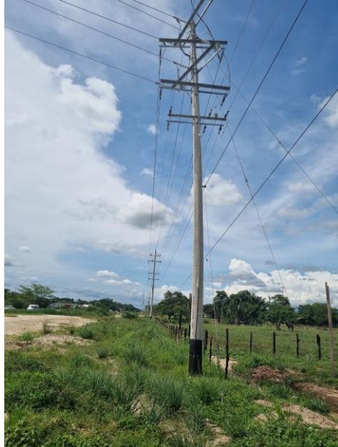
10°35'29.4"N 74°10'10.8"W, Poste de 18x1350 y SPT. (se solicitó equilibrar los esfuerzos sobre el poste)
