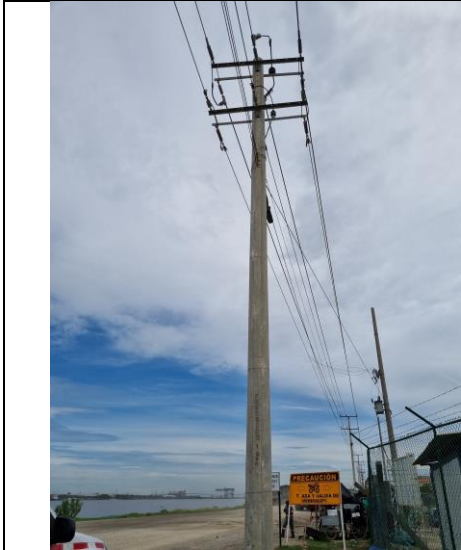
10°58'11.6"N 74°45'45.5"W, Estructura inicio tramo conductor 266 desnudo.
