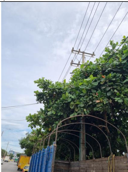
10°59'20.4"N 74°46'40.7"W, Estructura final tramo 5, cable AAAC 246,9 180 M
