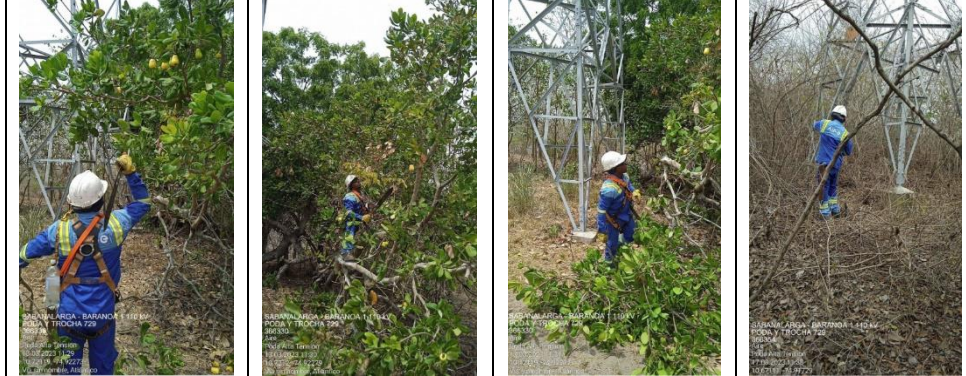
Fuente: Evidencias Air-e Informe de seguimiento I Trimestre 2023
