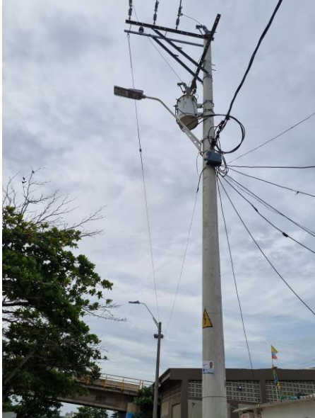
10°59'19.0"N 74°46'35.8"W, Poste de 12x1050 y estructura terminal tramo No 3 en cable AAAC 246,9, 130 ml
