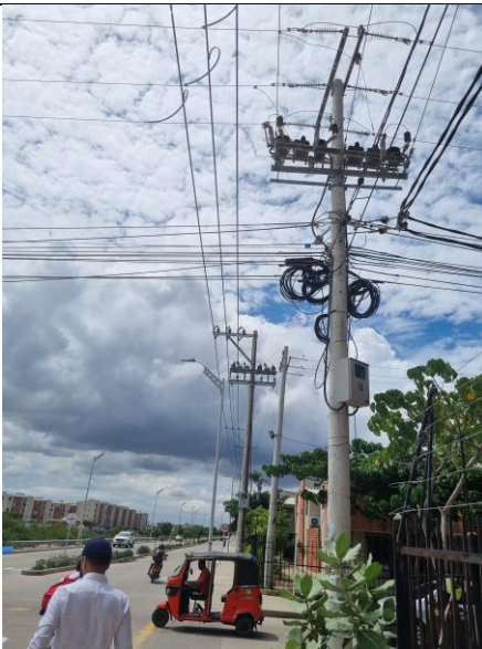
10°55'02.0"N 74°46'52.0"W, Cambio de dirección conductor
