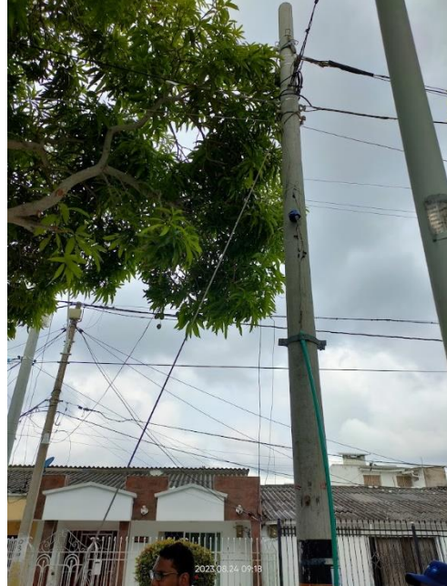
10°57'50.2"N 74°47'56.3"W AOE infraestructura de tercero retenida AP aparentemente energizada Fuente: SSPD visita en campo
