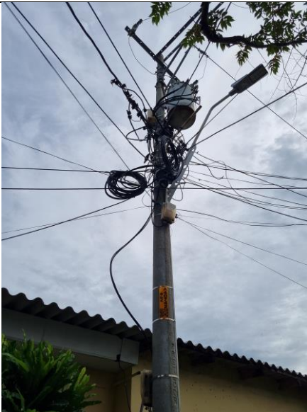
Estructura final tramo bifásico 45 metros.
