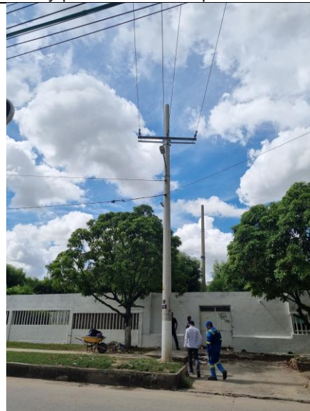
10°54'30.5"N 74°47'08.7"W, Poste de 12x1350 y/ puesta a tierra reportada, fin tramo No 2 AAAC 123, 410 ml.
