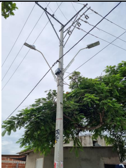
10°59'20.6"N 74°46'35.3"W, Estructura inicio tendido trifásico tramo 5, cable AAAC 246,9
