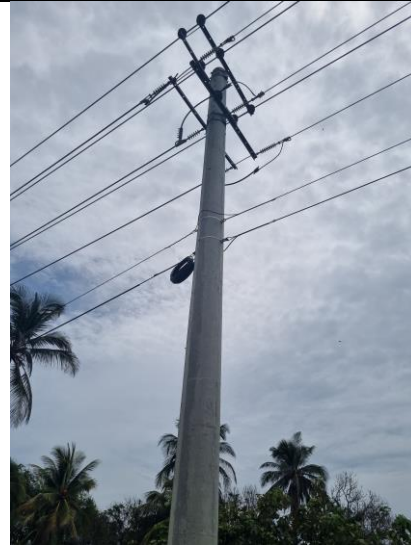
10°58'10.0"N 74°45'11.3"W, Estructura final tramo conductor 266 desnudo, 540 ml, inicia conductor 266 semiaislado.
