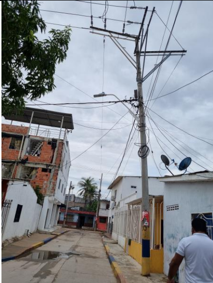
10°59'20.4"N 74°46'39.5"W, Estructura cambio de dirección eje de línea.
