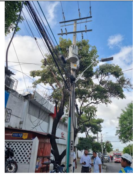
11°00'48.2"N 74°47'42.9"W, poste de 12x1050 y fin tramo 5 conductor 4/0, 350 ml
