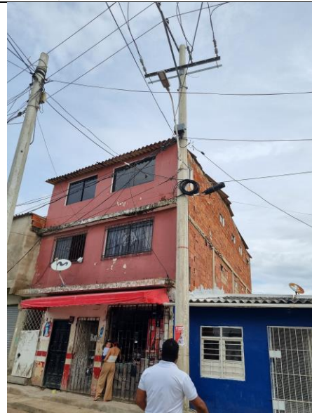
10°59'20.3"N 74°46'36.0"W, Poste de 12x1050 y fin tramo 4 230 ml.
