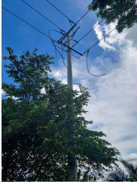
10°32'00.6"N 74°10'53.3"W, Poste de 16x2500 y SPT, cambio dirección cruce vía.
