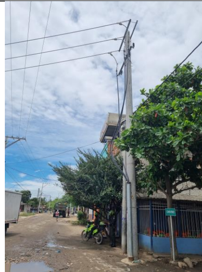
10°57'32.4"N 74°44'42.1"W, Cruce en cable 266 semiaislado, 20 ml
