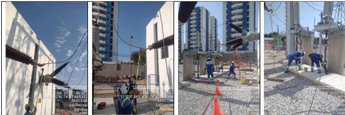
Fuente: Evidencias Air-e Informe de seguimiento I Trimestre 2023
