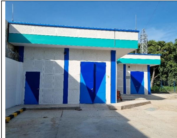
Caseta de control, UC NOP13
