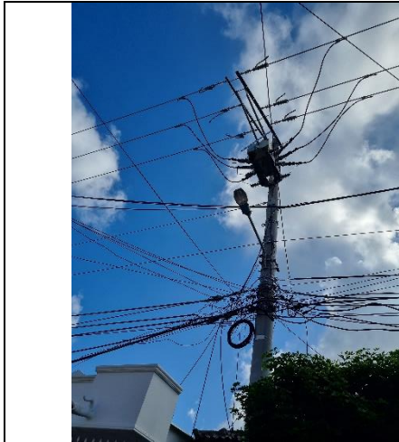
10°54'48.6"N 74°46'01.6"W, Estructura inicio tramo 1 cable 394.5
