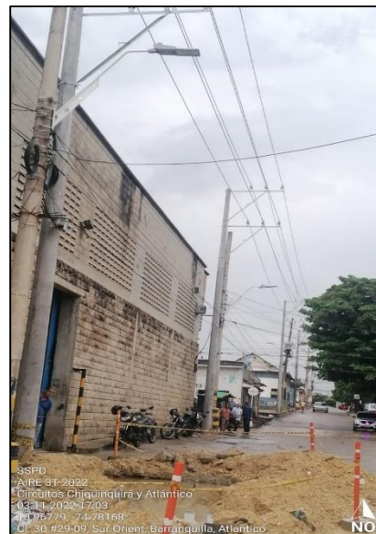
Circuito Chiquinquirá y Atlántico – Reemplazo ACSR
