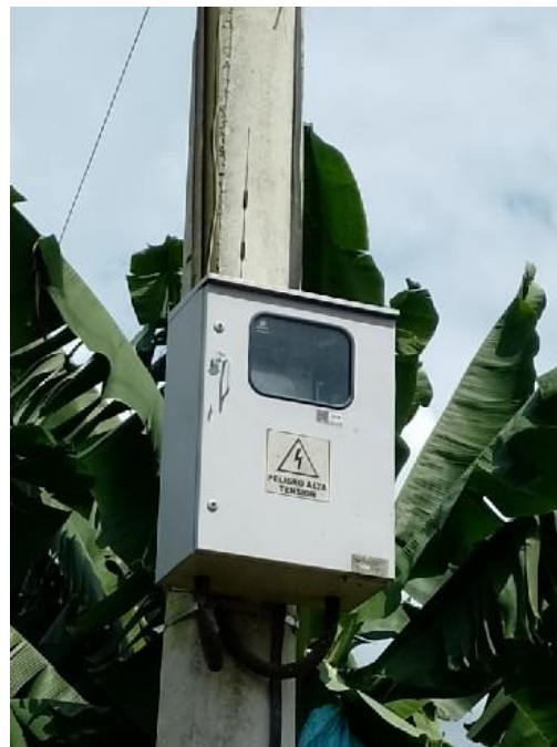
Localización 10.8364195, -74.1434773 Fuente: SSPD visita en campo
