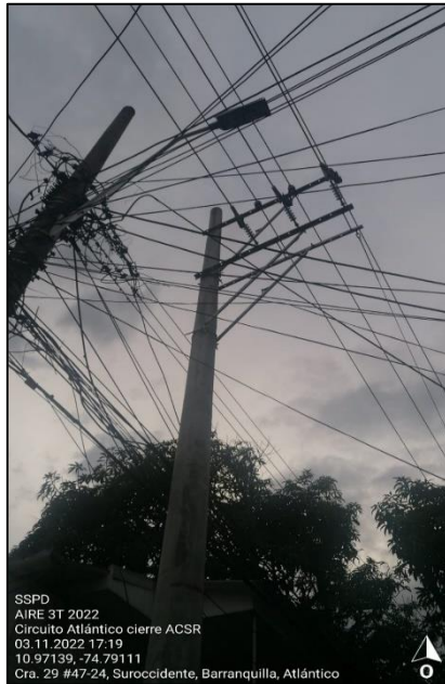
Circuito Atlántico – Reemplazo ACSR
