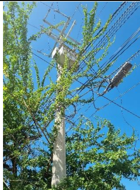
10°56'45.2"N 74°45'53.0"W, Estructura final tramo No 3, 657 metros.
