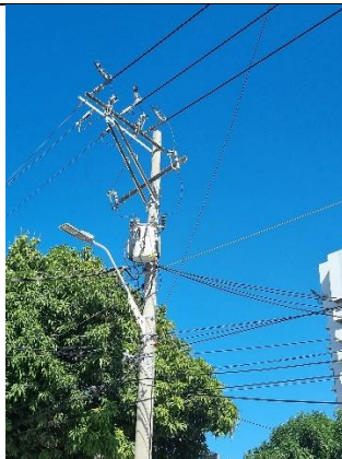
10°58'36.4"N 74°47'25.6"W, Estructura inicio cable CF200.
