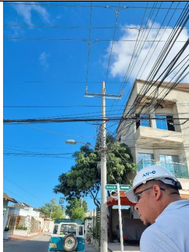
10°55'19.1"N 74°45'51.0"W, Estructura final tramo 1 cable 394.5.
