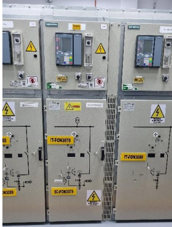
Celda salida circuito Fonseca 1 - UC N2S9
