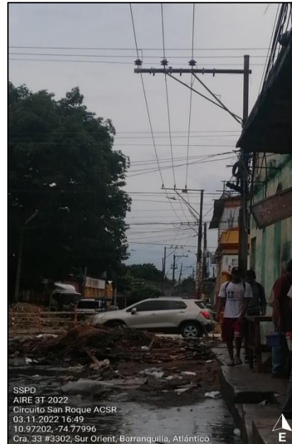
Circuito San Roque - Reemplazo ACSR
