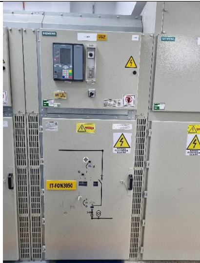
Celda de acople barra sencilla – UC N2S11
