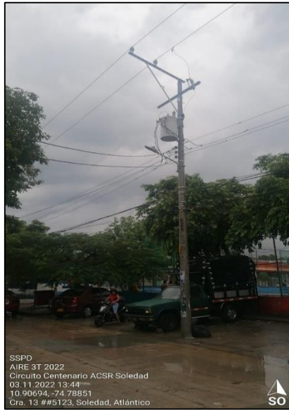
Circuito Centenario – Reemplazo ACSR
