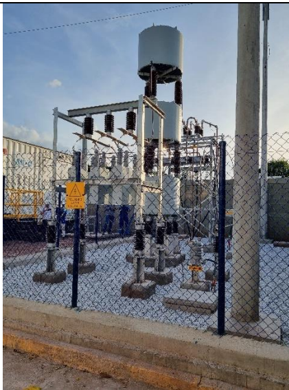
Banco compensación tipo pedestal 13,8 KV, 3 MVAR – UC N2EQ3E
