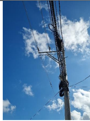
10°55'18.9"N 74°45'50.5"W, Estructura final tramo 2
