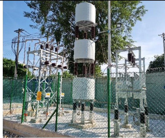
Compensación Fonseca 13,8 KV, 3 MVAR N2EQ3E
