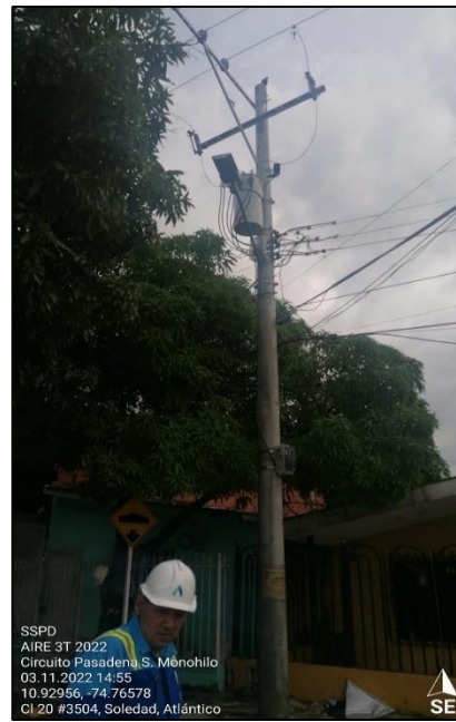
Circuito Pasadena _Sustitución Red Monohilo
