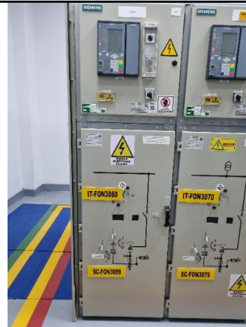
Celda de medida o auxiliares barra sencilla – UC N2S12
