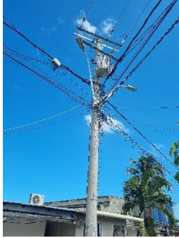
10°56'47.6"N 74°45'49.1"W, Estructura final segundo tramo AAAC 123, 467 metros.
