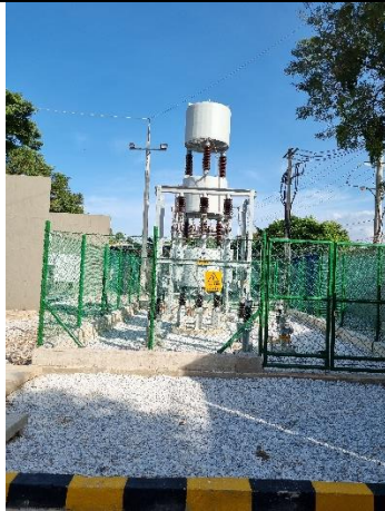
Compensación Fonseca 13,8 KV, 3 MVAR N2EQ3E
