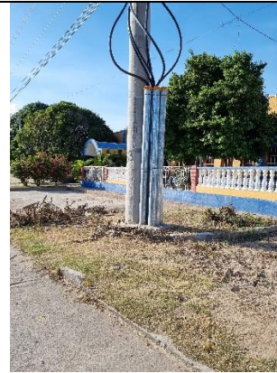
Salida Canalización
