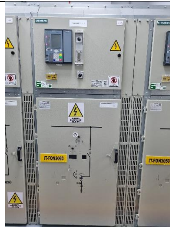
Celda llegada transformador barra sencilla – UC N2S10
