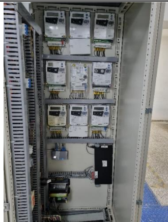
Equipo de medida N2 – 4UND- (2 primera fila, 2 segunda fila de izquierda a derecha)- UC N2EQ10
