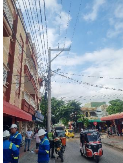
10°55'36.6"N 74°46'17.6"W, Estructura final tramo 6, 93 ml aproximadamente.
