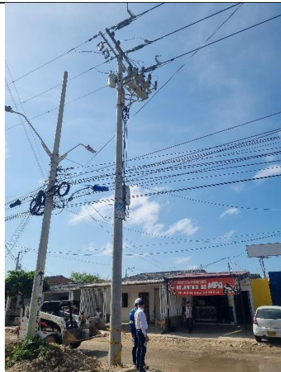
11°01'59.6"N 74°52'03.7"W, Estructura inicio tramo 3 en CF159.
