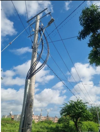
10°56'05.1"N 74°49'39.3"W, Estructura terminal tramo 1 en cable CF200, 955 ml.
