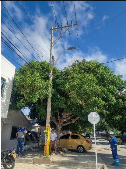
10°58'30.3"N 74°48'48.1"W, Estructura inicio tramo No 3 en cable AAAC 123.
