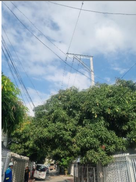
10°55'35.2"N 74°46'20.9"W, Estructura inicio tramo No 5
