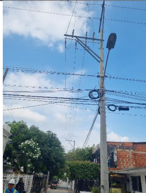
10°55'33.7"N 74°46'12.1"W, Final tramo 2 en ACSR 1/0, 134 metros aproximadamente.
