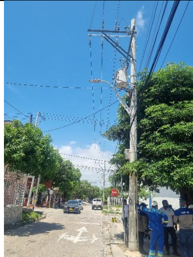
10°58'51.1"N 74°50'13.2"W, Estructura inicial tramo 8 en cable AAAC 246,6, 120 ml, poste de 12x1030 y tierra reportada
