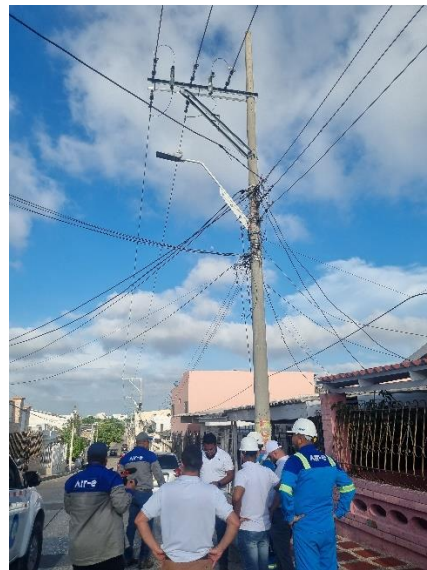
10°58'20.5"N 74°48'31.5"W, Estructura terminal tendido trifásico en cable 4/0, 509 metros
