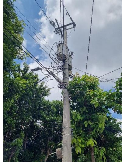
10°58'06.2"N 74°48'24.0"W, Estructura final tramo 2 CF63, 148 ml.
