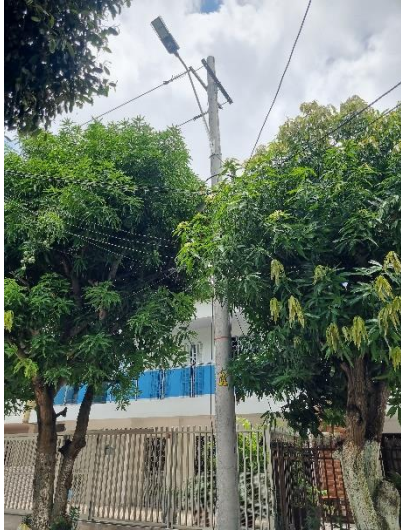
10°58'18.2"N 74°48'10.5"W, Estructura inicio tramo 2 CF63.
