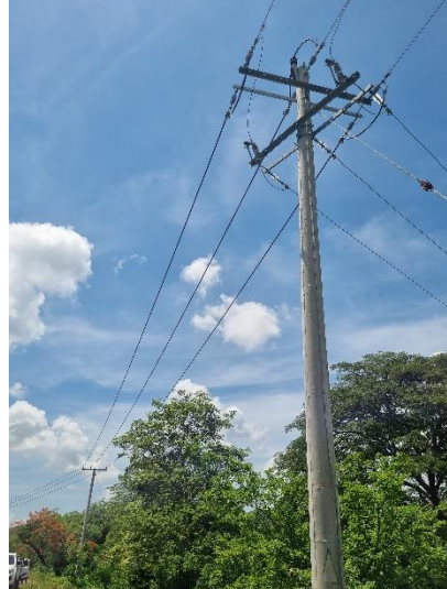
10°48'26.8"N 75°07'40.5"W, Estructura final tramo 5 en cable CF125 y poste de 12x1324, 1 km.
