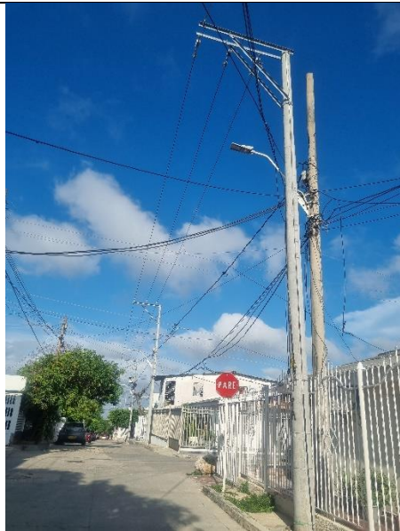
10°58'23.6"N 74°48'47.4"W, Estructura inicio tendido trifásico en cable 4/0
