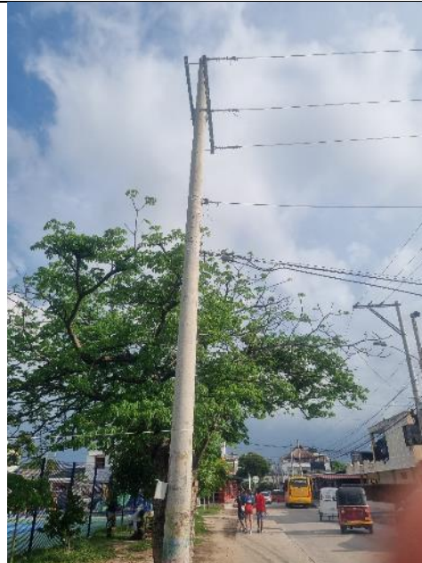
10°55'35.4"N 74°46'17.8"W, Estructura final del tramo No 5, aproximadamente 77 metros
