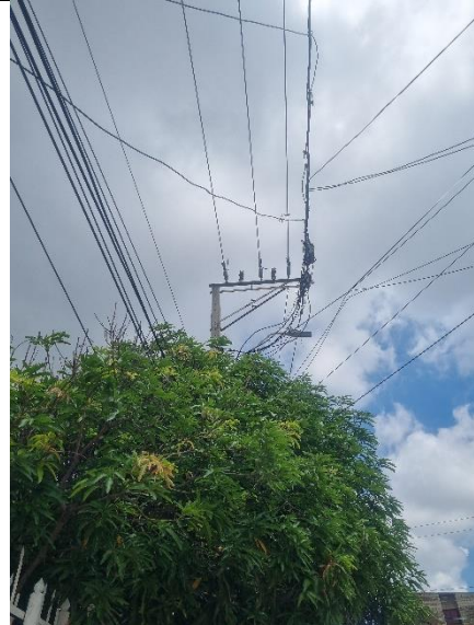
10°57'47.9"N 74°48'34.0"W, Estructura final tramo 3 en conductor CF63, 393 ml
