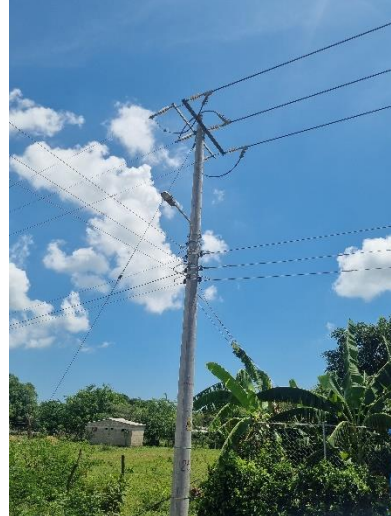
Poste de 12x1324 y fin tramo No 4 en cable CF125. 1,5 km
