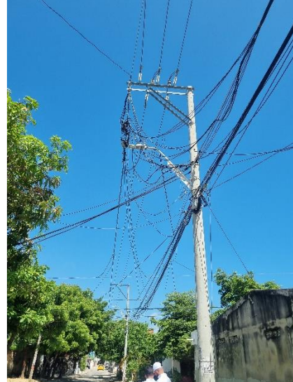
10°58'48.8"N 74°50'25.3"W, Estructura final tramo 4 en cable AAAC 246,6.
