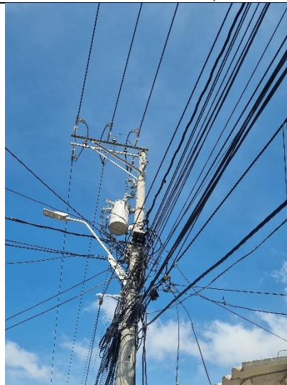
Estructura fin de tramo CF159, 350 ml
