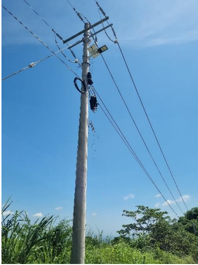
10°45'24.9"N 75°06'27.9"W, Estructura final tramo 3 en cable CF159 subida a piojo, 1 km
