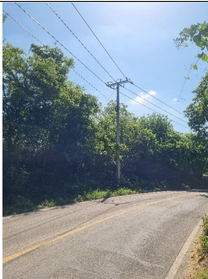
10°48'34.6"N 75°05'21.3"W, Estructura de terminación tramo No 2 en cable CF125, 672 ml
