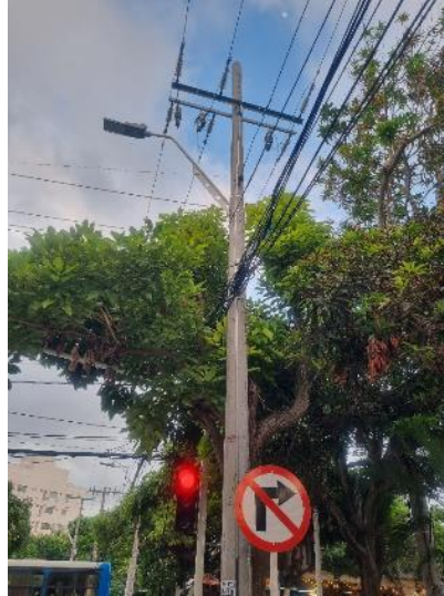
11°00'38.1"N 74°49'29.3"W, Estructura final tramo cable ACSR 1/0, 260 ml aproximadamente
