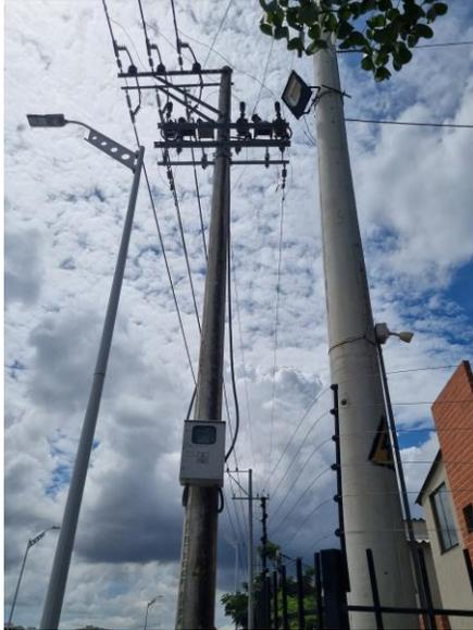
10°55'02.2"N 74°46'52.0"W, Poste de 14x1324 y inicio tramo 2 conductor AAAC 123
