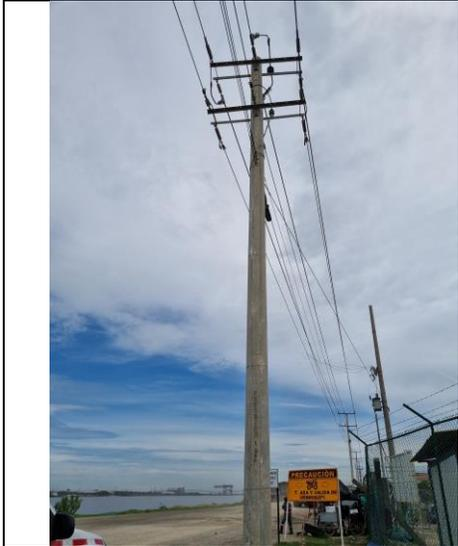
10°58'11.6"N 74°45'45.5"W, Estructura inicio tramo conductor 266 desnudo.
