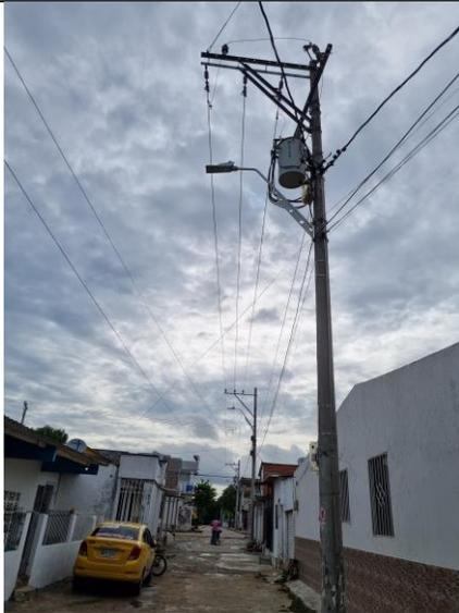
10°59'22.6"N 74°46'41.5"W, Estructura inicio tramo 1 conductor AAAC 246,9.
