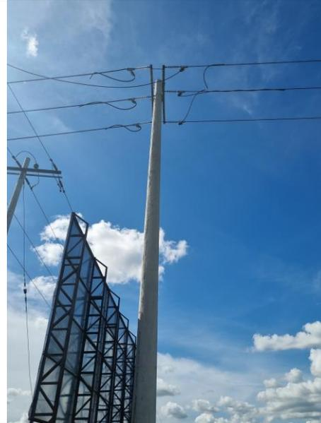
10°32'01.2"N 74°10'51.4"W, Poste de 16x2500 y SPT, fin tramo semiaislado 336 Kcmil. 4.930 metros
