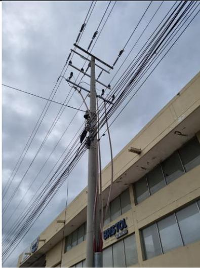
11°01'49.3"N 74°48'25.9"W, Estructura inicio tramo circuito Rayón Norte, en conductor 477 Kcmil.
