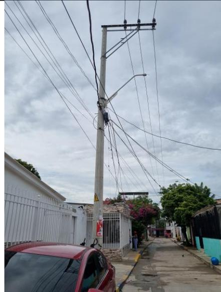
10°58'27.2"N 74°48'32.1"W, Estructura final tramo 1 en cable AAAC 123, 420 ml.
