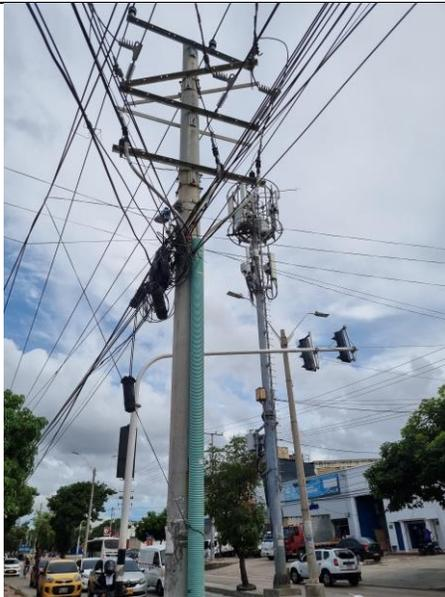
11°01'34.9"N 74°48'13.7"W, Estructura de terminación tramo circuito SIAPE en Conductor 336 Kcmil, 600 ml
