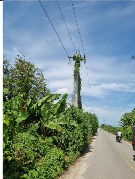
10°44'32.4"N 74°09'16.2"W, Poste de 14x2500 y SPT, fin tramo 1 conductor 394, 570 ml.
