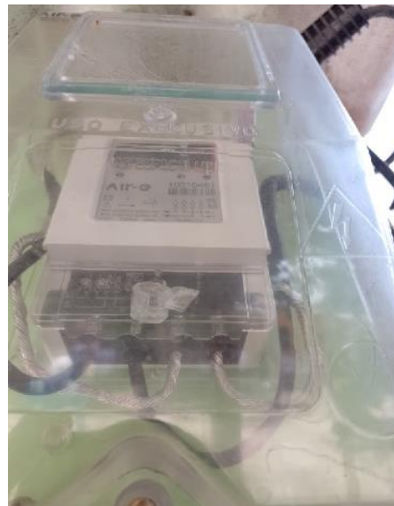
Localización: 11.009103, -74.257236 Fuente: SSPD visita en campo
