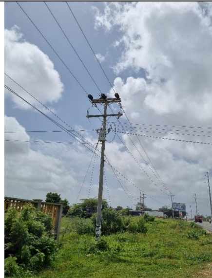
Estructura terminal cambio 900 metros de conductor
