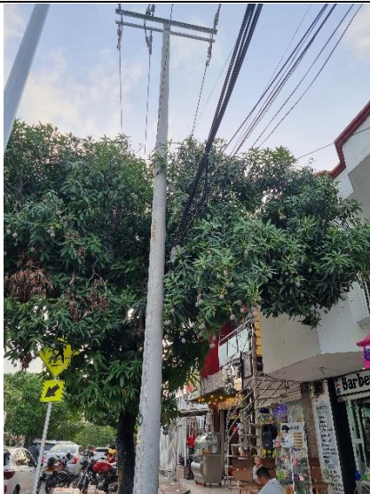
10°56'54.3"N 74°47'12.6"W Poste inicio circuito cambio conductor AAAC 394
