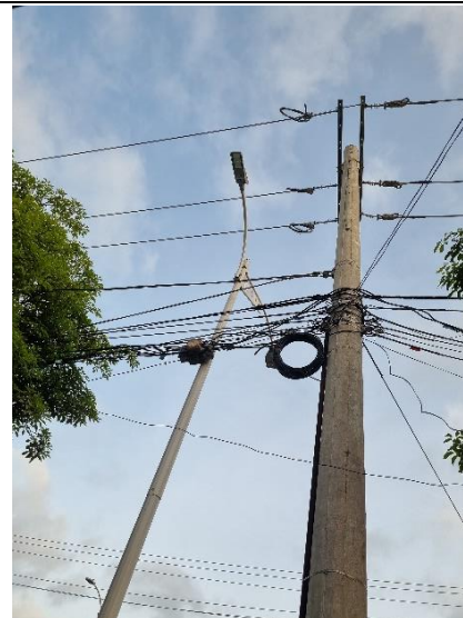
10°56'45.7"N 74°47'38.8"W Estructura final tramo AAC 394- 1700 metros
