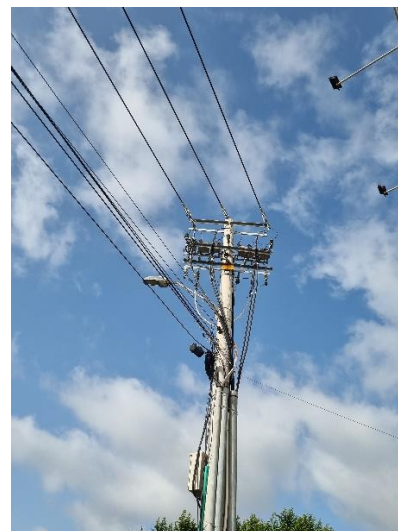
11°00'56.5"N 74°52'40.9"W Final 2do tramo cable 336 Kcmil aislado – 1250 metros – bomba gasolina
