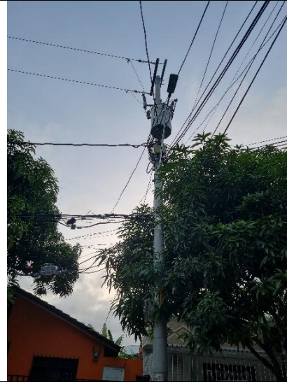
Estructura final tramo 2H 1/0 -200 metros
