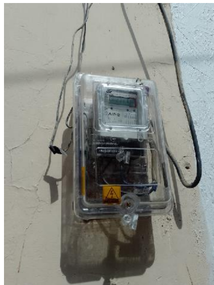
Localización: 11.007356, -74.248882 Fuente: SSPD visita en campo
