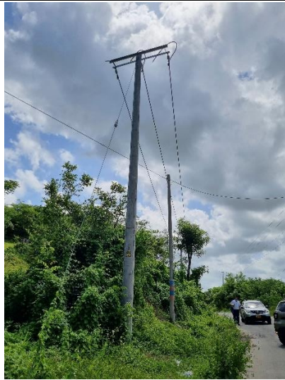
10°48'38.3"N 75°04'40.2"W} Inicio tramo cable ecológico y poste 12x1324
