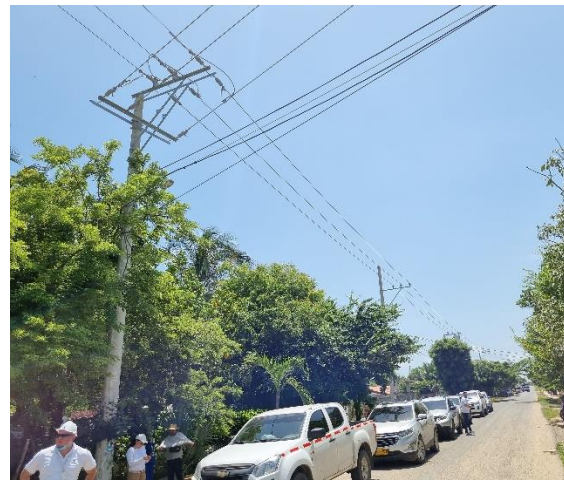
10°52'55.8"N 75°04'20.6"W Estructura final cable 266 Kcmil- 1300 metros
