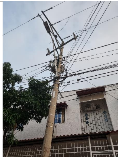
10°56'32.1"N 74°47'22.0"W Estructura final tramo 3H en 1/0
