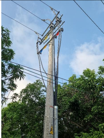
10°56'54.3"N 74°47'12.6"W Poste inicio circuito cambio conductor AAAC 394
