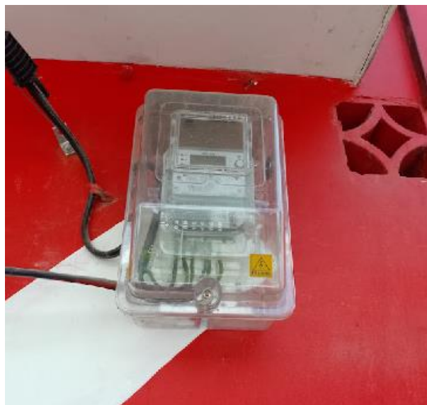
Localización: 11.007896, -74.249496 Fuente: SSPD visita en campo
