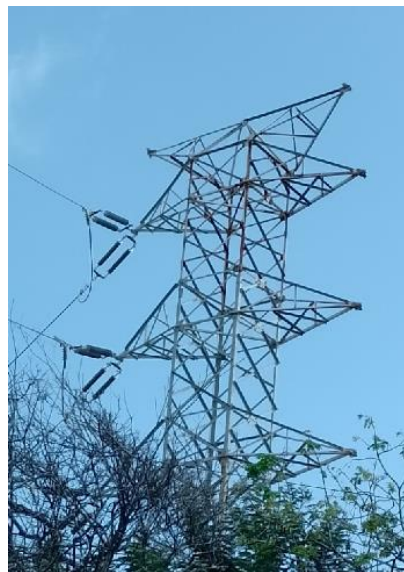
Localización: 11.024412, -74.811234 Fuente: SSPD visita en campo
