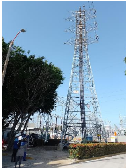
Localización: 11.025845, -74.811182 Fuente: SSPD visita en campo
