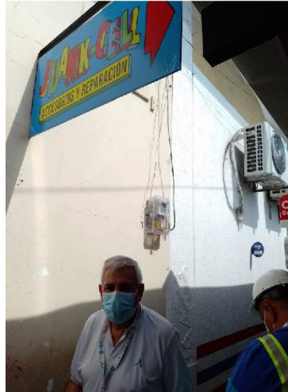
Localización: 11.007356, -74.248882 Fuente: SSPD visita en campo
