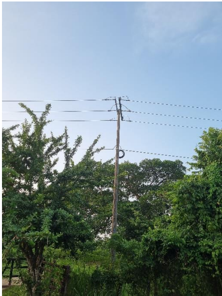
Termina tramo cambio conductor por 123,3 AAC 350 metros e inicia cambio conductor por 312,8 AAC
