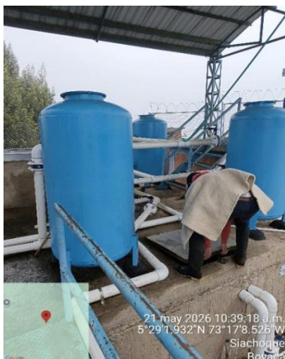
Imagen 32. Sistema de filtración
