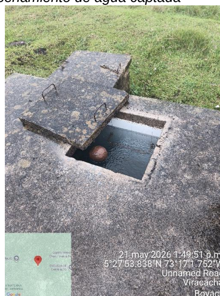
Imagen 44 e Imagen 45. Tanques de almacenamiento de agua captada
