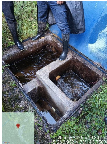
Imagen 9. Cámara lateral captación río Juyasia
