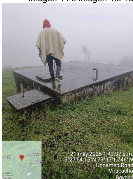
Imagen 44 e Imagen 45. Tanques de almacenamiento de agua captada
