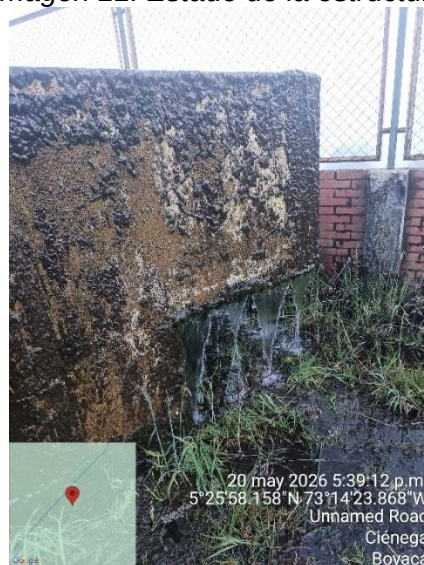
Imagen 11. Estado de la estructura
