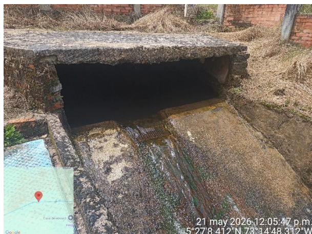
Imagen 25. Bocatoma quebrada Paso Blanco
