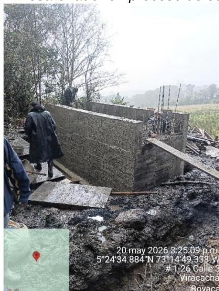
Imagen 37. Desarenador en proceso de construcción
