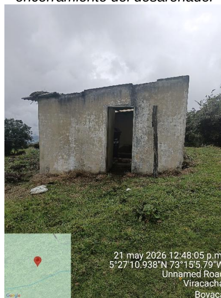
Imagen 28. Estructura de encerramiento del desarenador
