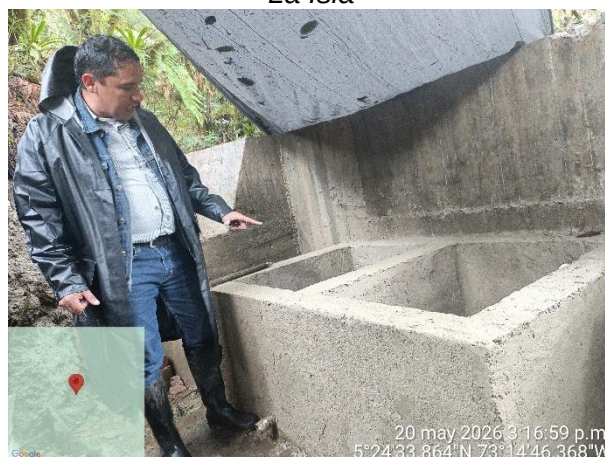
Imagen 36. Cámara lateral captación quebrada La Isla
