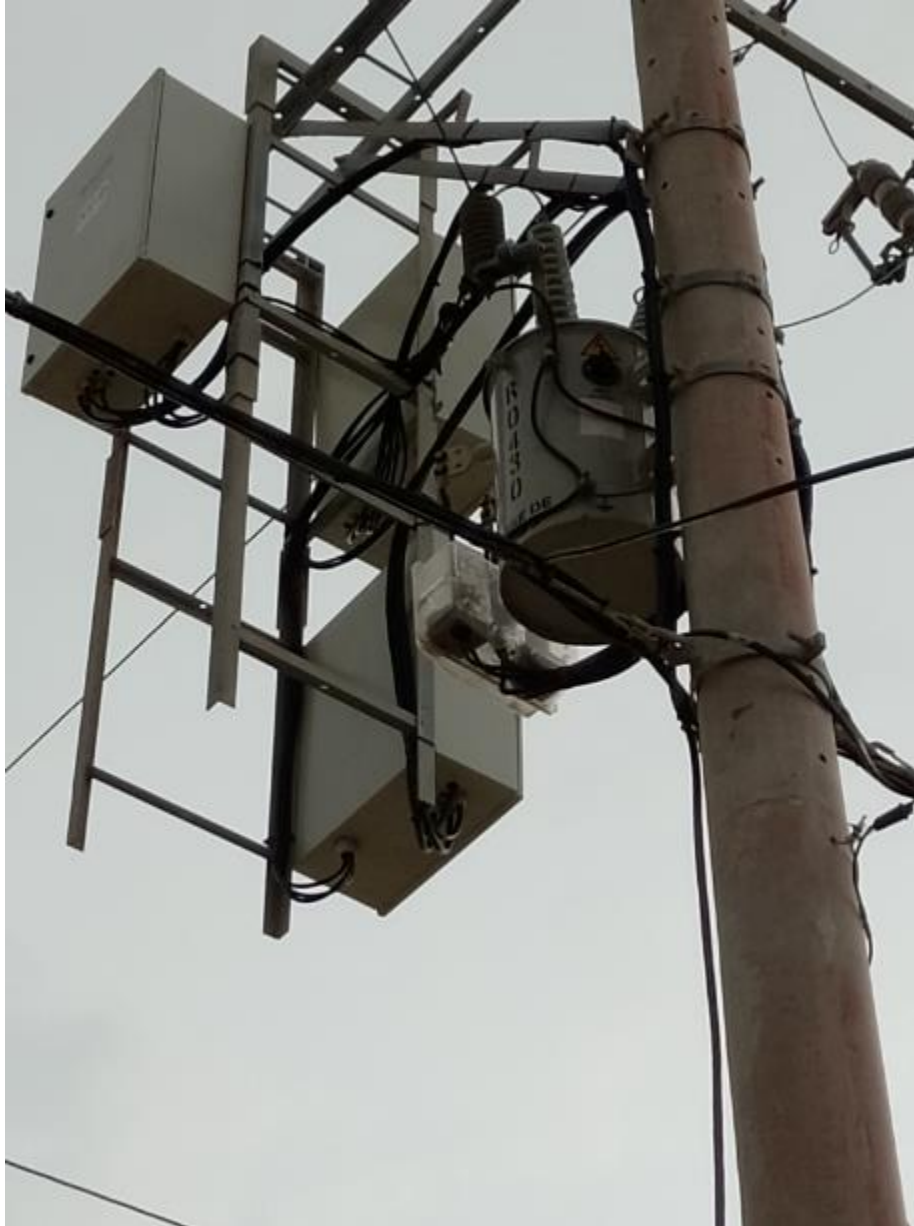
Proyecto Puerto Colombia 2da etapa
