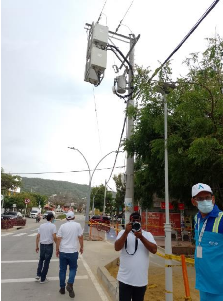
Proyecto Puerto Colombia 2da etapa
