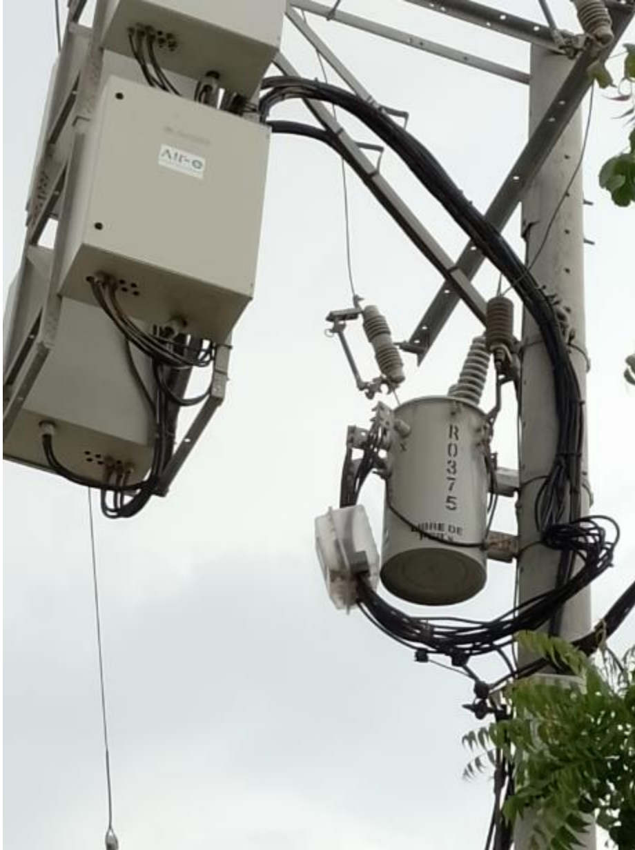
Proyecto Puerto Colombia 2da etapa
