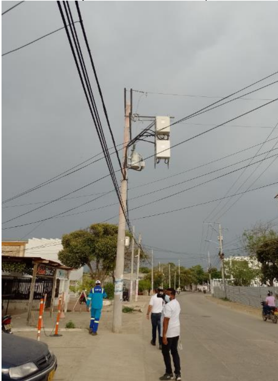
Proyecto Puerto Colombia 2da etapa
