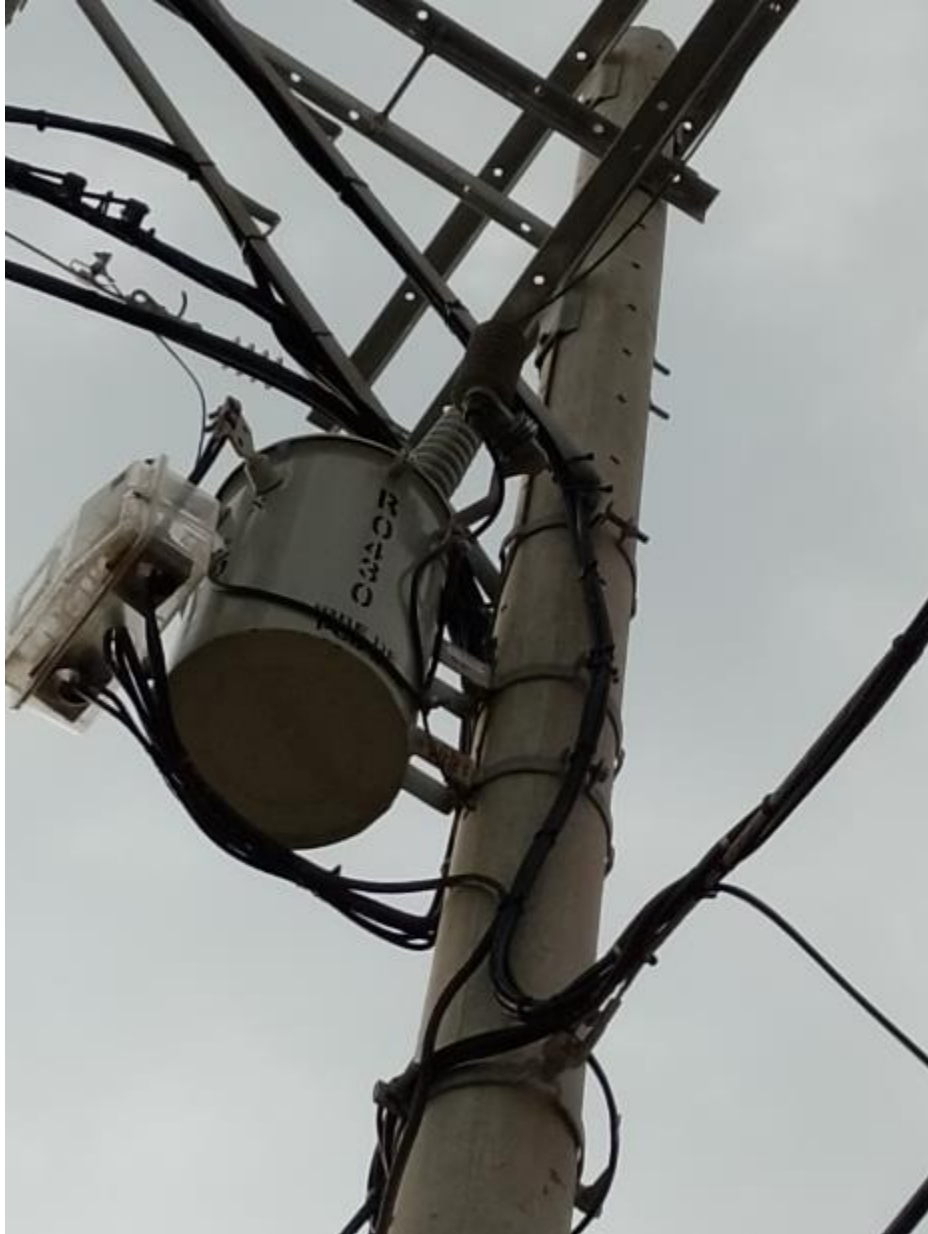
Proyecto Puerto Colombia 2da etapa
