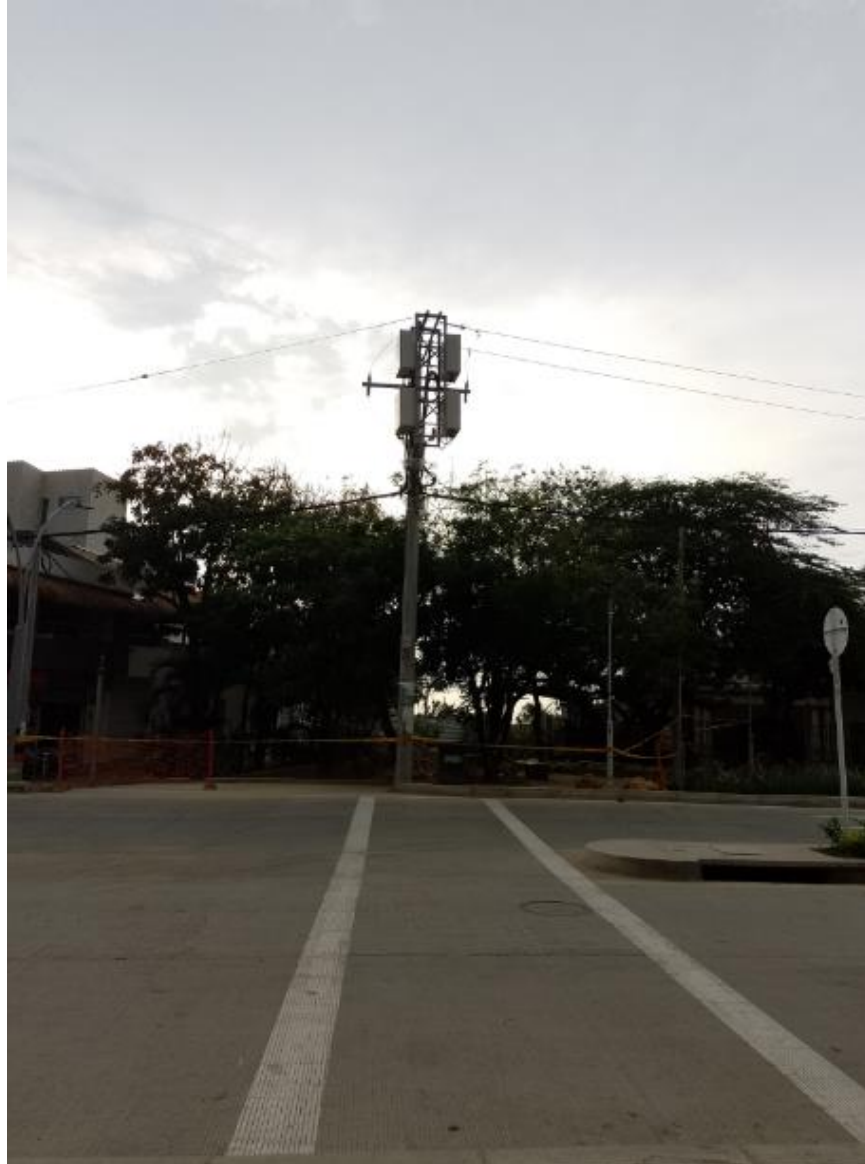
Proyecto Puerto Colombia 2da etapa
