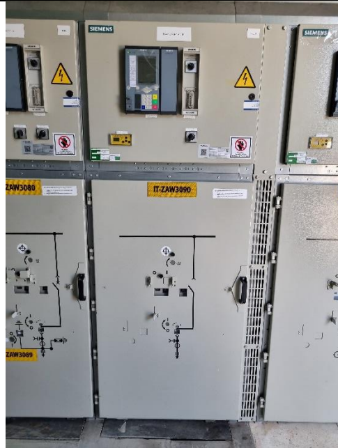
Celda transformador
