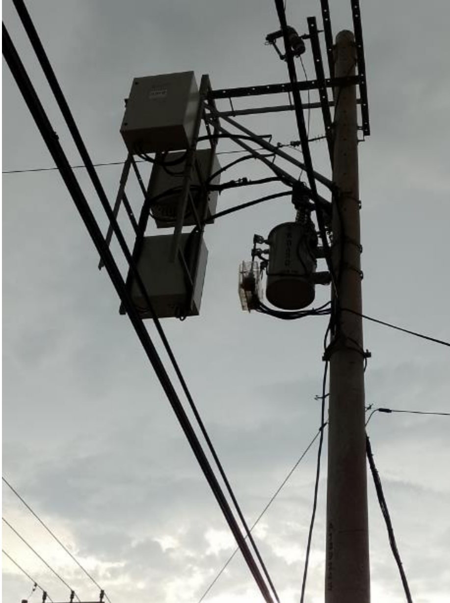
Proyecto Puerto Colombia 2da etapa
