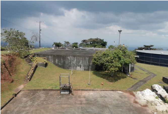
Tanques de almacenamiento
