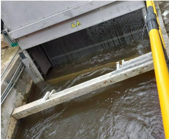
Cribado fino automatizado
