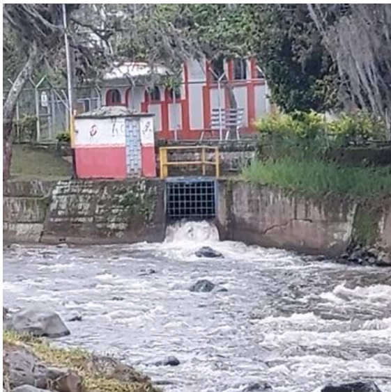
Captación Lateral Chidral
