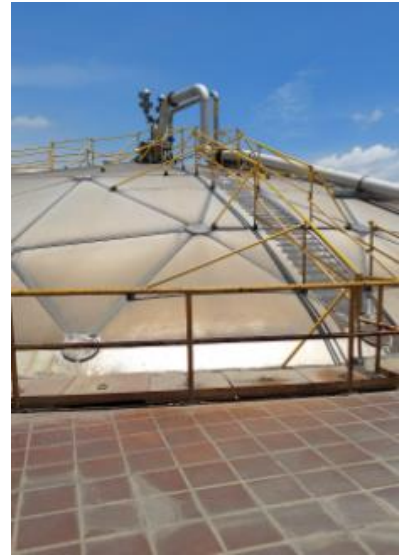
Digester anaerobio
