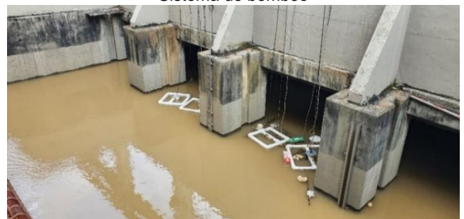
Sensores de oxígeno disuelto y turbiedad
