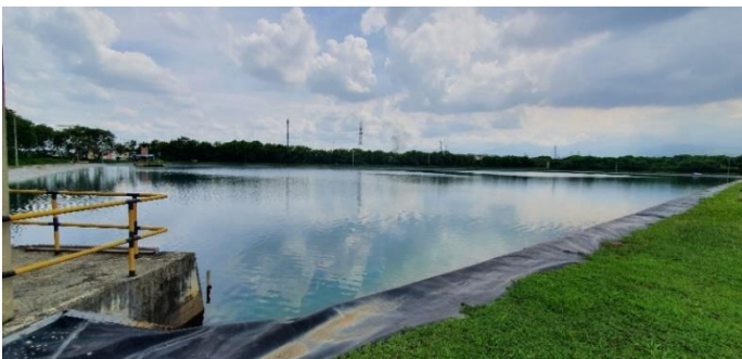
Reservorio de 80.000 m 3
