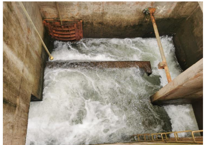
Cámara de entrada
