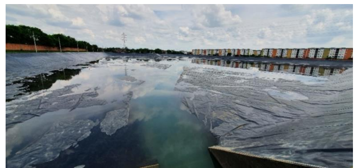
Reservorio de 100.000 m 3
