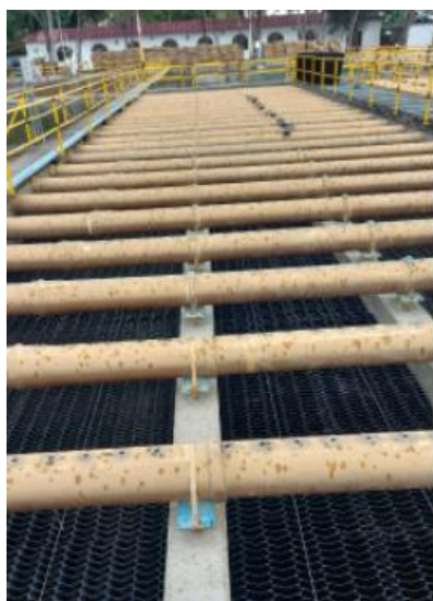
Cambio a lamelas sedimentador 1
