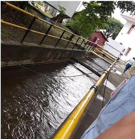
Canal de entrada
