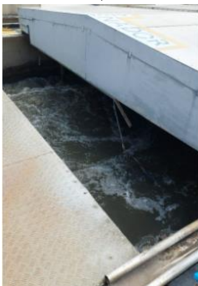
Desarenador aireado
