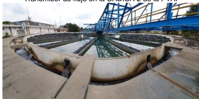
Reactor de manto de lodos
