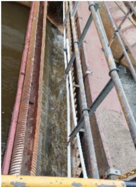
Dosificación de coagulante
