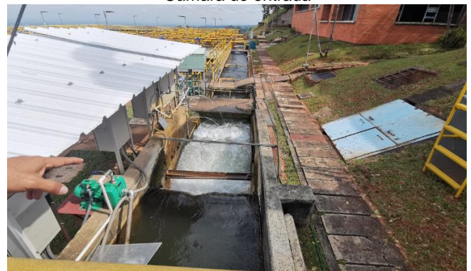
Resalto Hidráulico de entrada
