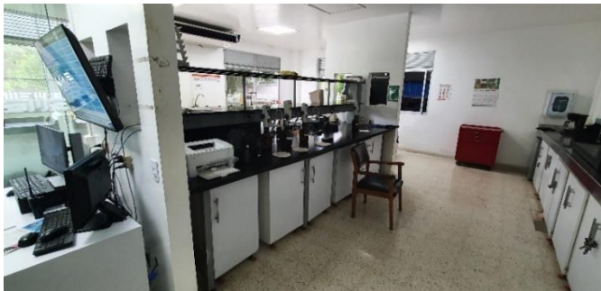
Laboratorio de control de tratamiento PTAP Puerto Mallarino
