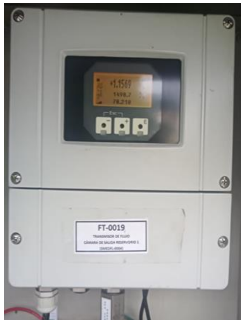
Transmisor de flujo reservorio Fuente: Registro fotográfico SSPD
