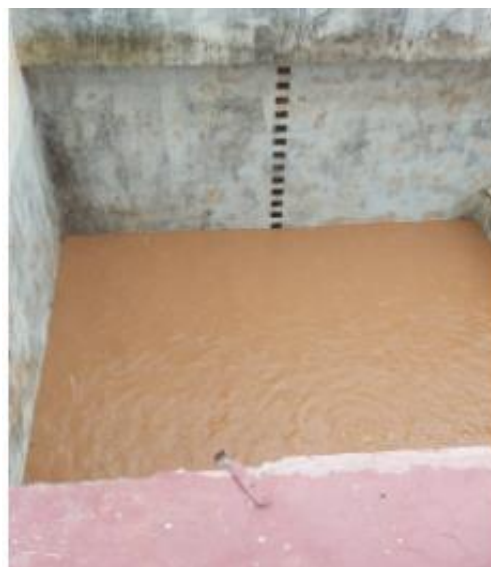
Se apaga la inyección de aire
