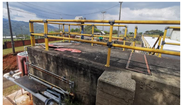
Cámara de entrada
