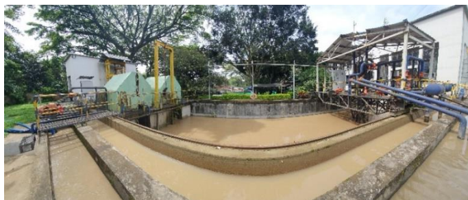
Desarenador y puente móvil
