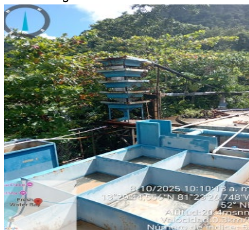
Imagen 10. Torre de Aireación
