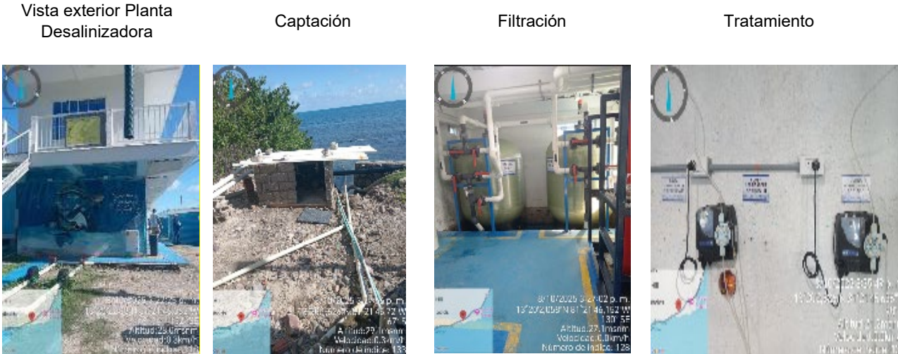
Imagen 20. Componentes Planta Desalinizadora Agua Mansa
