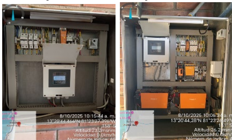
Imagen 18. Macromedidores agua Potabilizada
