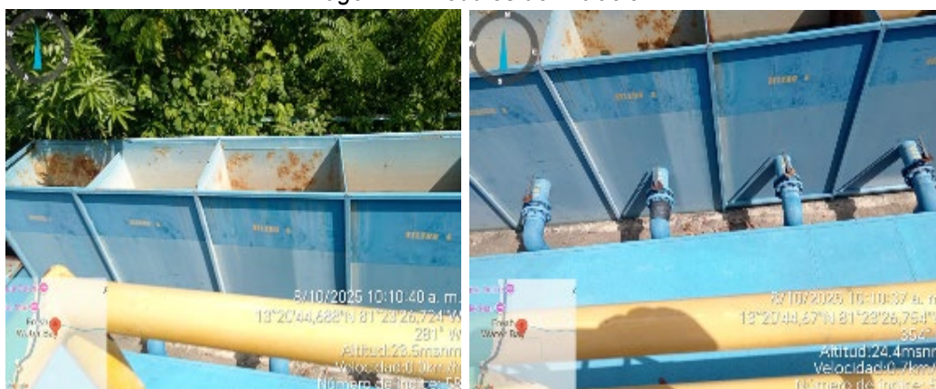
Imagen 14. Módulos de Filtración
