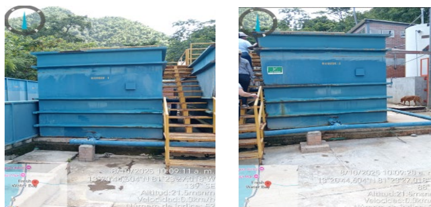
Imagen 11. Módulo 1 y 2 para el tratamiento Mezcla Rápida
