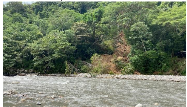
Deslizamiento en el talud - sector "Cafarnaúm"
