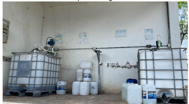
Área de almacenamiento y dosificación de productos químicos
