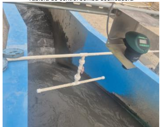
Sistema de difusores tipo Thomson y medidor de nivel
