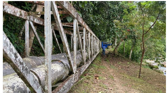
Estructuras de protección en la línea de conducción
