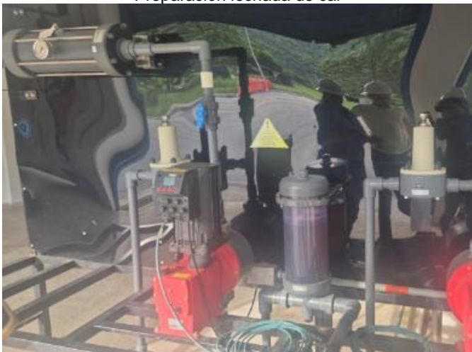
Bombas dosificadoras coagulante
