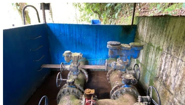
Válvulas de control de salida hacia la PTAP Alterna y Conciliada
