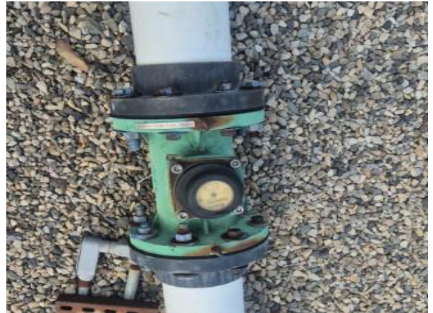
Macromedidor entrada no funcionando
