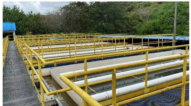
Sedimentadores tipo colmena
