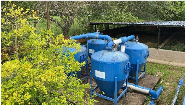
Homogenización mediante hidrociclones
