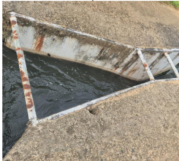
Canaleta Parshall salida
