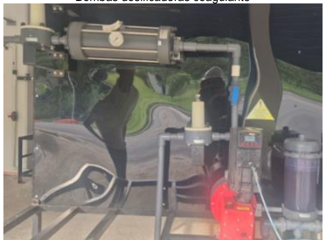
Bombas dosificadoras alcalinizante
