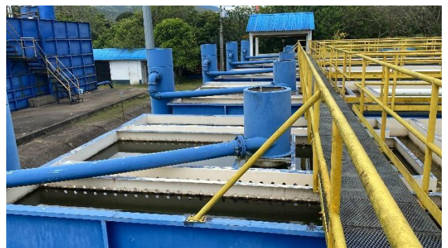
Tanques de floculación
