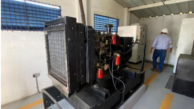
Grupo electrógeno de respaldo
