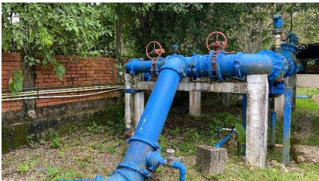
Válvula de control de caudal y presión de ingreso al sistema
