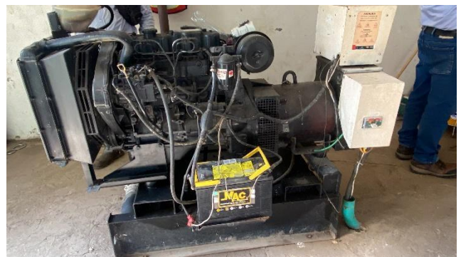
Planta de respaldo sin capacidad para iniciar equipos de bombeo
