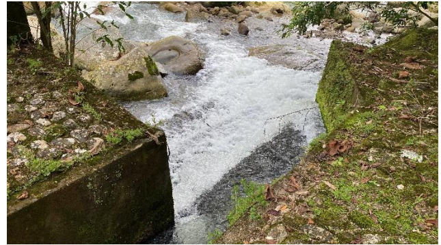
Descarga del caudal de excesos a la quebrada La Tablona
