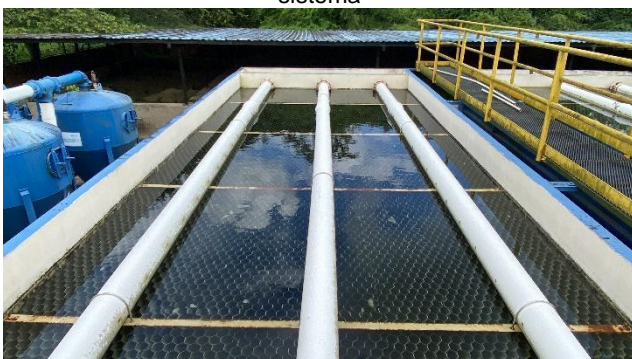
Sedimentadores tipo colmena
