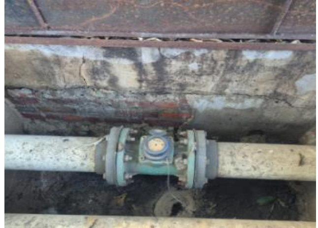
Macromedidor entrada no funcionando
