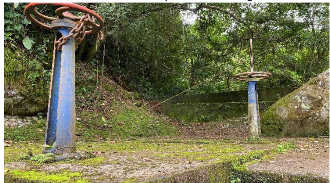
Válvulas de control de caudal en bocatoma
