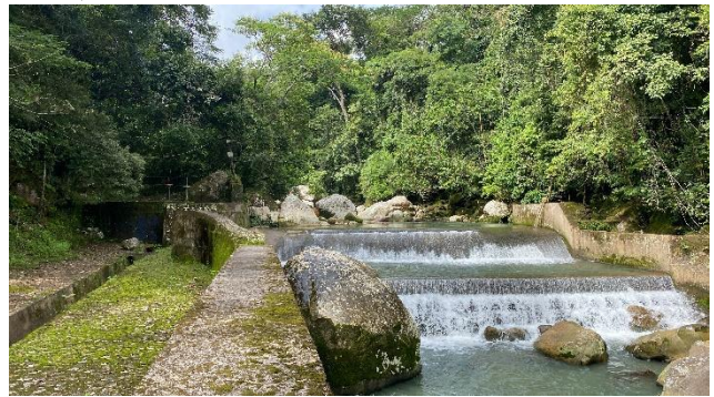
Estructura de disipación de energía
