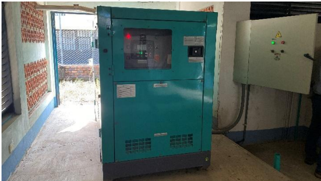
Grupo electrógeno de respaldo
