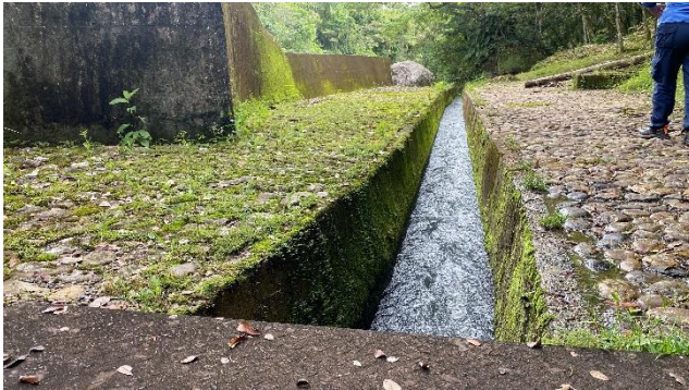
Canal revestido de caudal de excesos
