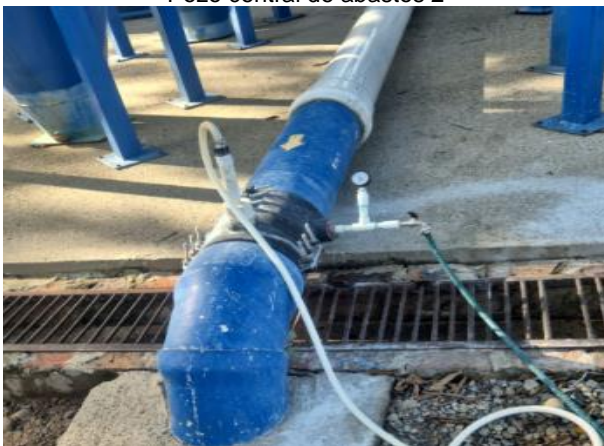
Punto de inyección de cloro
