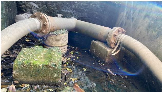
Flauta de salida al colector principal
