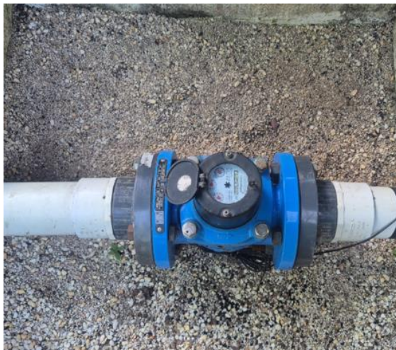
Macromedidor salida fuera de uso
