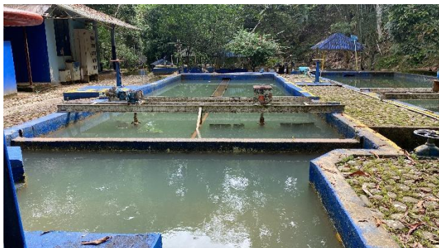
Sedimentador principal - 1ª línea de 16"
