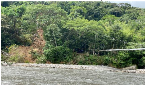
Deslizamiento en el talud - sector "Cafarnaúm"
