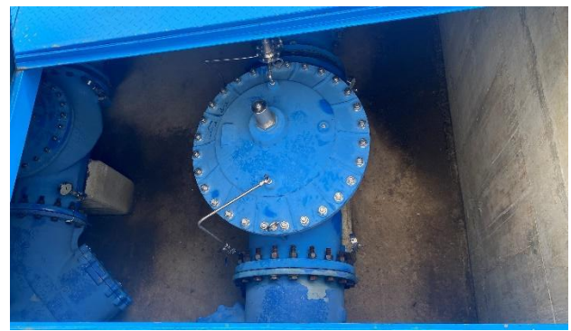
Macromedidor de salida
