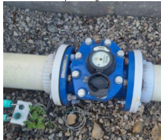
Macromedidor salida de planta
