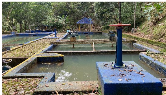
Sedimentador principal - 2ª línea de 16"
