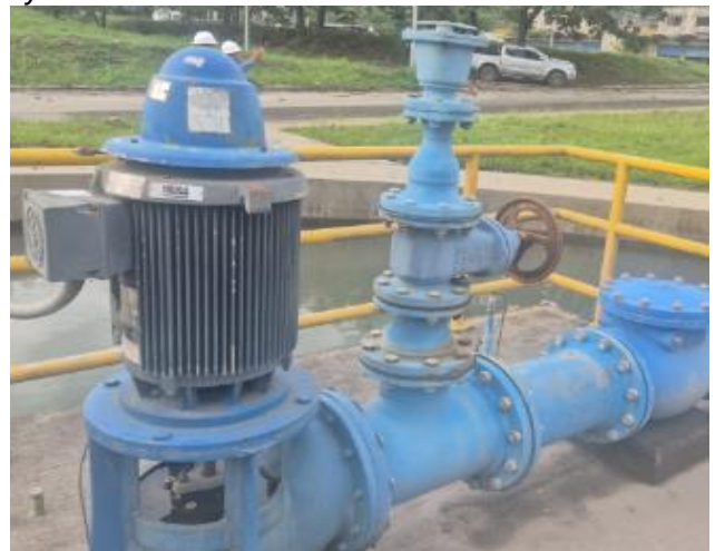
Bomba tanque de retorno
