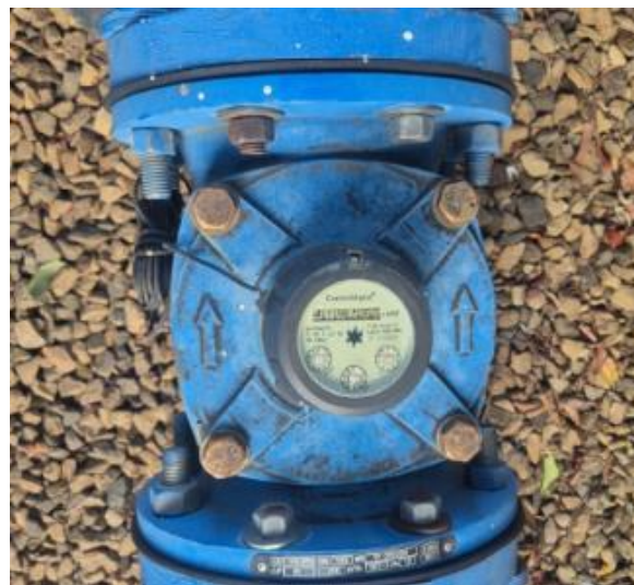
Macromedidor salida de planta
