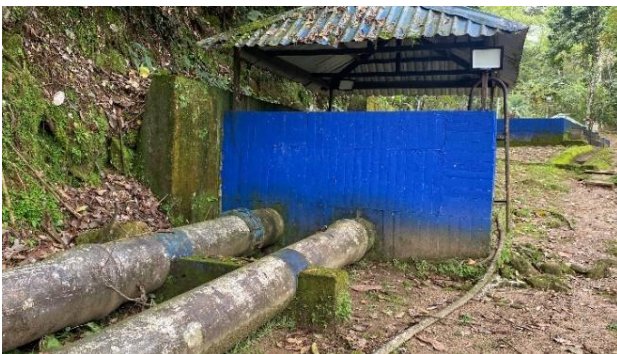
Salida en paralelo del sistema de pretratamiento
