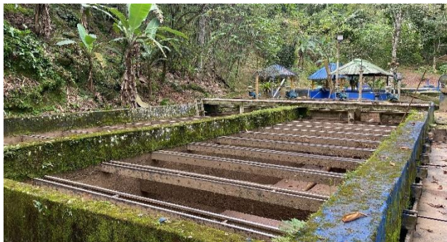
Sedimentador secundario línea de 18"
