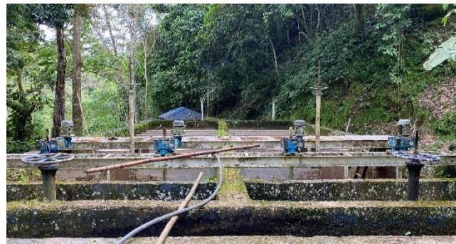
Sedimentador secundario línea de 18"
