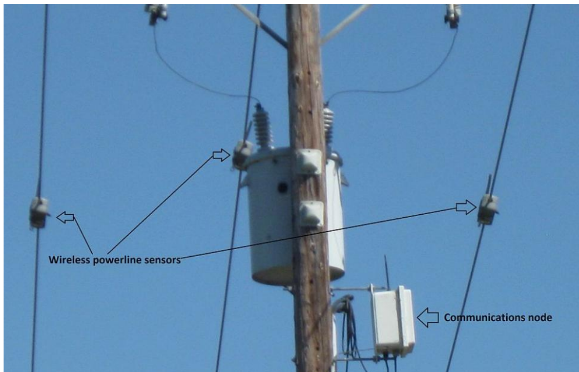
Fig. 3-6: Ejemplo de instalación de Nodo de Comunicaciones para algunas localidades ZNI Fuente: https://www.revolv.com/page/Wireless-powerline-sensor
