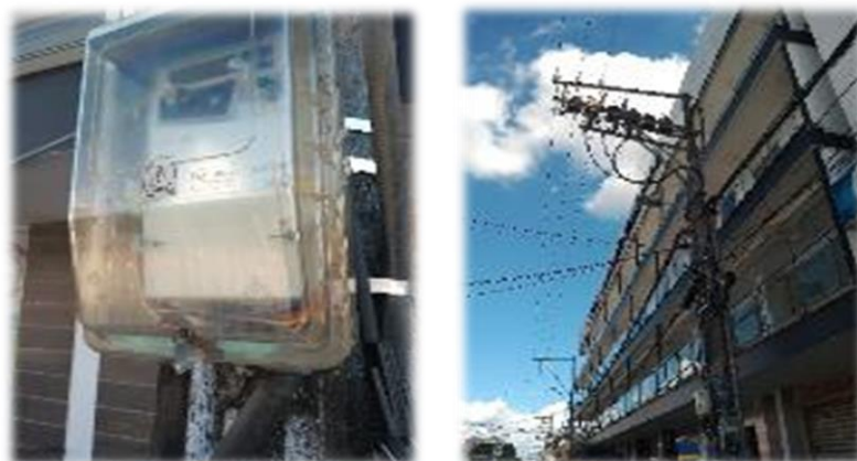
Imagen No. 25 Intervenciones en usuarios grandes consumidores en Montería
