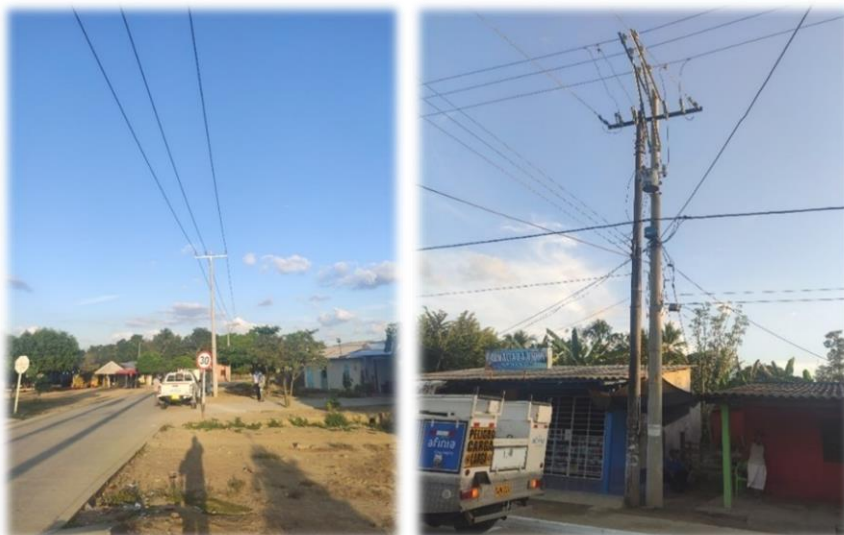
Imagen No. 3. Proyecto reposición circuito Carrillo
