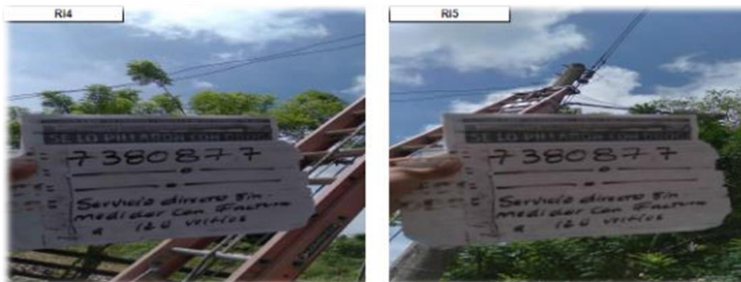
Imagen No. 36 Instalación de medidores a usuarios sin medidor en Santa Lucia, Sucre
