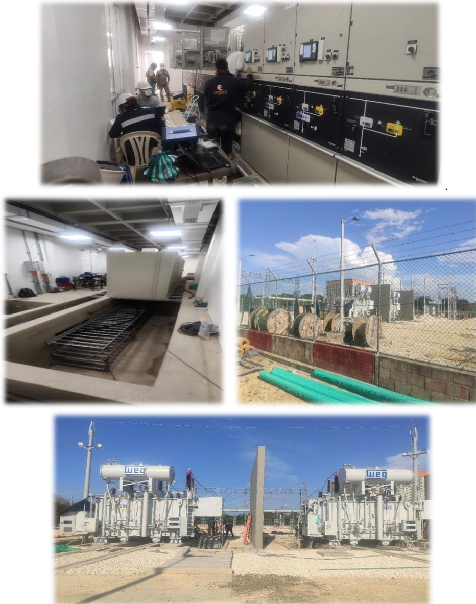
Imagen No. 10 Evidencias fotográficas obras de la nueva subestación Manzanillo en el SDL
