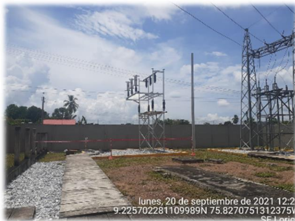
Imagen No. 15 Instalación del banco de condensadores SE Lorica– Córdoba
