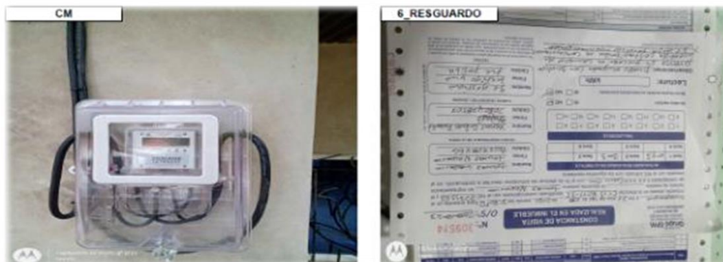
Imagen No. 32 Instalación de medidores a usuarios sin medidor en Magangue, Bolívar
