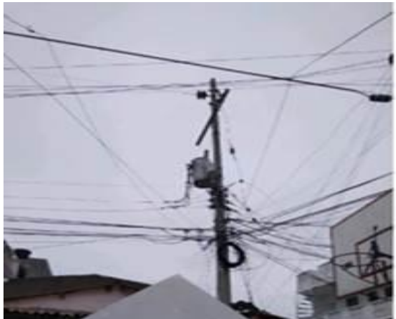
Circuito Zaragocilla 2 - 0,93 Kms de Red Intervenidos
