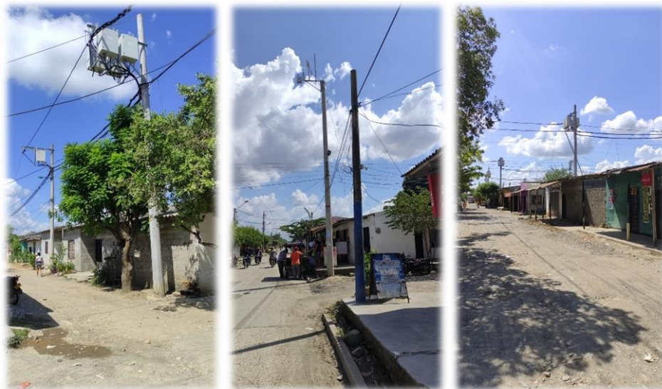
Imagen No. 44 Proyecto de medición Avanzada y aseguramiento de red en Montería, Córdoba
