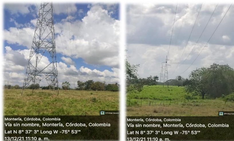
Imagen No. 11 Obras de mejora línea 758 - Rio Sinú Tierra 110 kV
