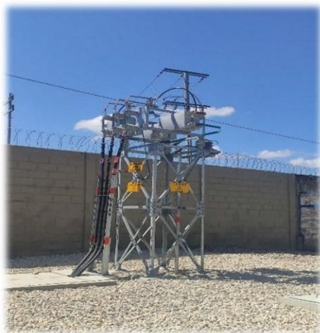
Imagen No. 16 Instalación banco de condensadores de 2 MVAR SE Corozal, Sucre
