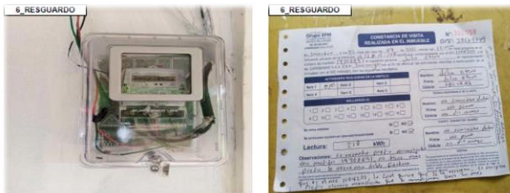
Imagen No. 33 Instalación de medidores a usuarios sin medidor en Sahagún, Córdoba.
