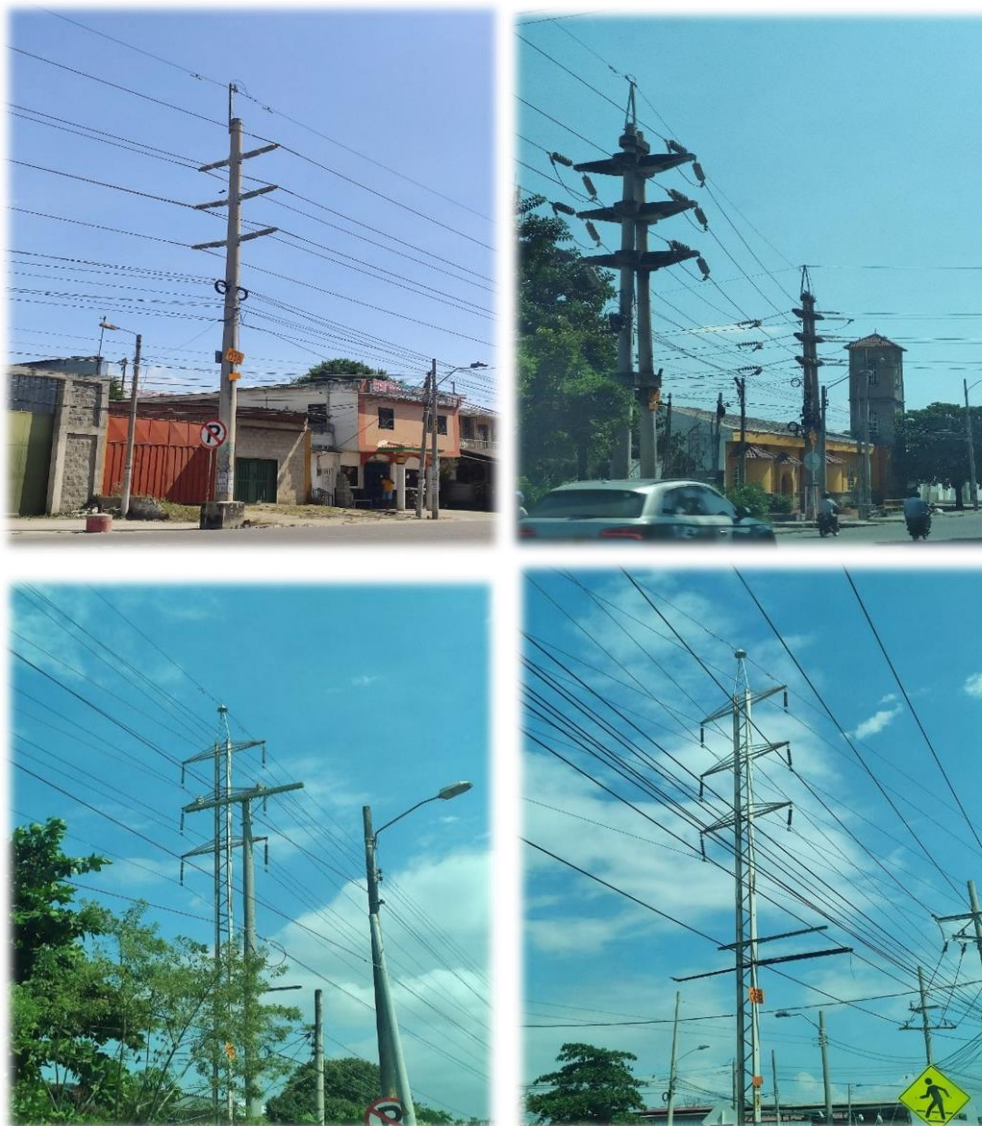
Imagen No. 13 Obras realizadas en la líneas 610, 619 y 620
