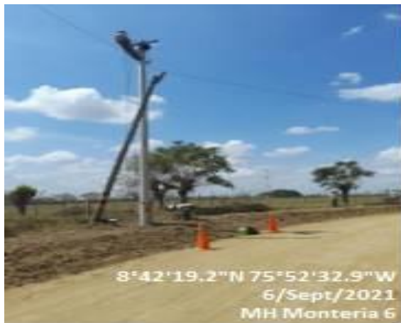
Circuito Montería 6 - 5,15 Kms de Red Intervenidos
