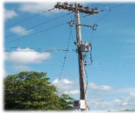
Imagen No. 29 Instalación de macromedida en.
