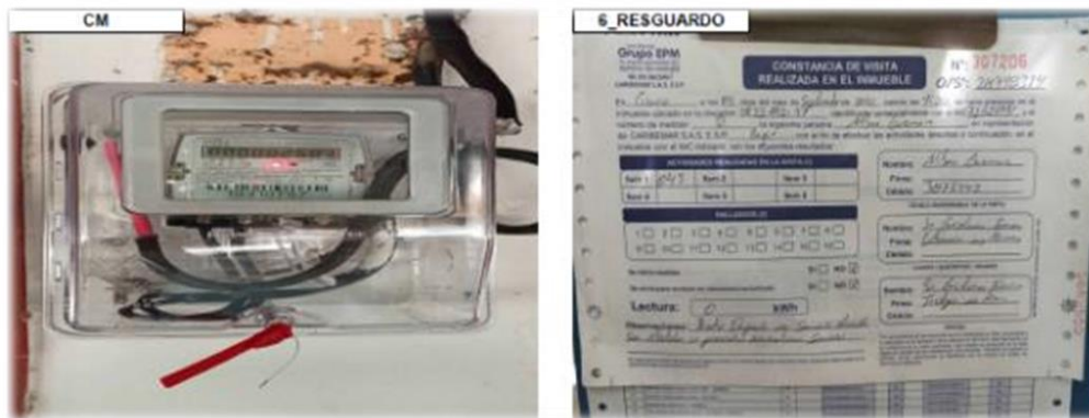
Imagen No. 31 Instalación de medidores a usuarios sin medidor Cicuco, Bolívar
