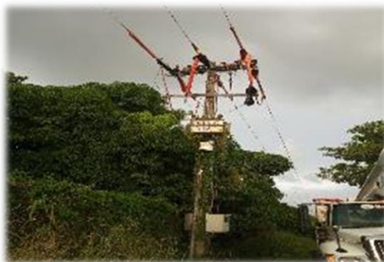
Imagen No. 30 Instalación de macromedida en Monteria, Cordoba.
