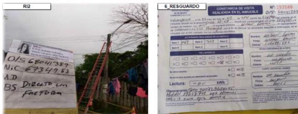
Imagen No. 34 Instalación de medidores a usuarios sin medidor en Ciénaga de Oro, Córdoba
