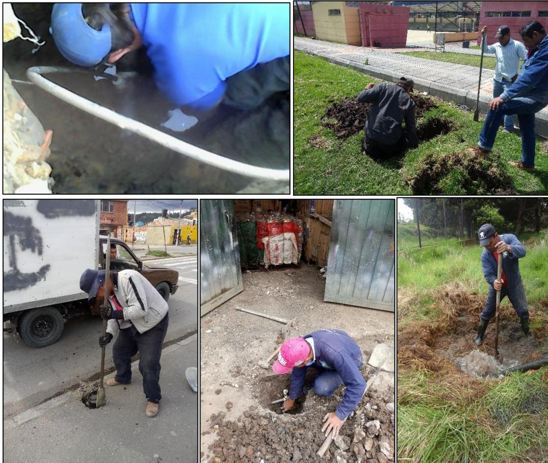
Teniendo en cuenta que no fue posible realizar los ajustes necesarios para emplear el equipo de detección de fugas no visibles, se plantea como medida alterna realizar jornadas de inspección del sistema de alcantarillado, con el fin de verificar que, en caso de presentarse fugas no visibles, que descarguen a la red de alcantarillado, estas sean detectadas y reparadas de acuerdo a los protocolos correspondientes.
