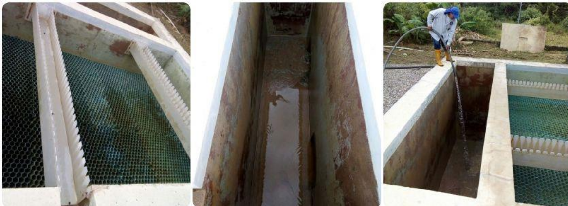
Lavado del tanque de sedimentación lenta
