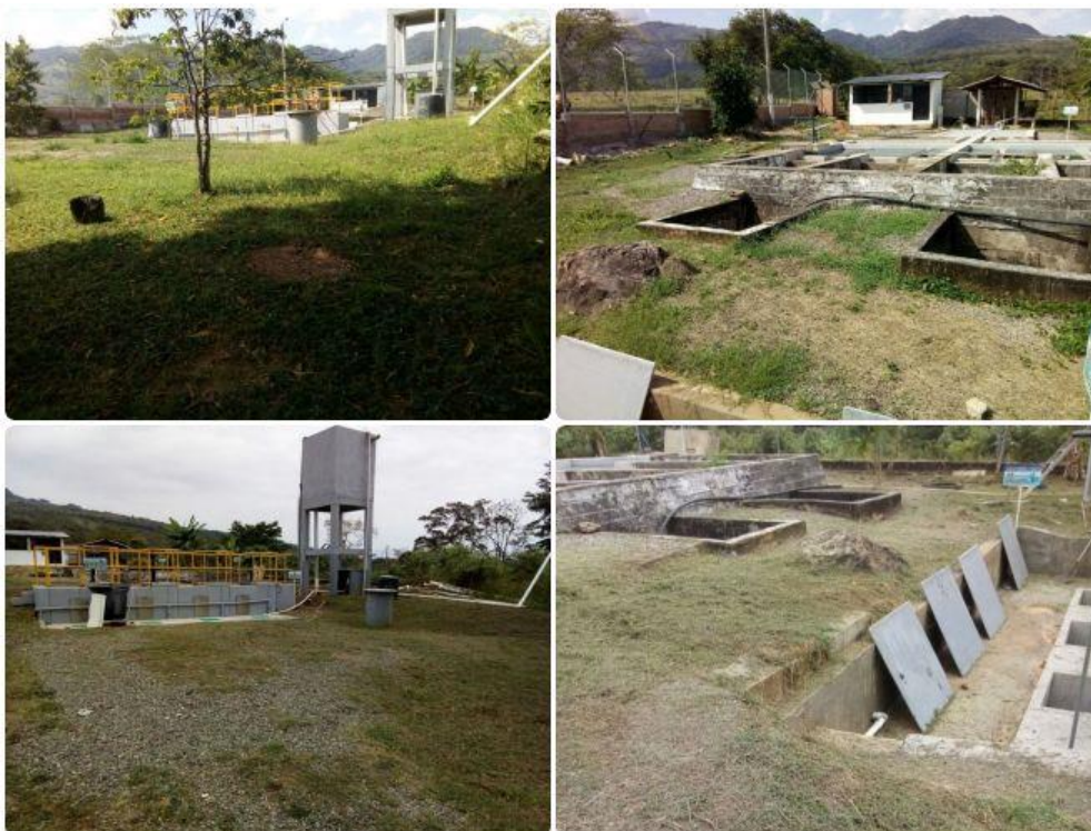
Limpieza del perímetro de la Planta de Tratamiento de Agua Potable
