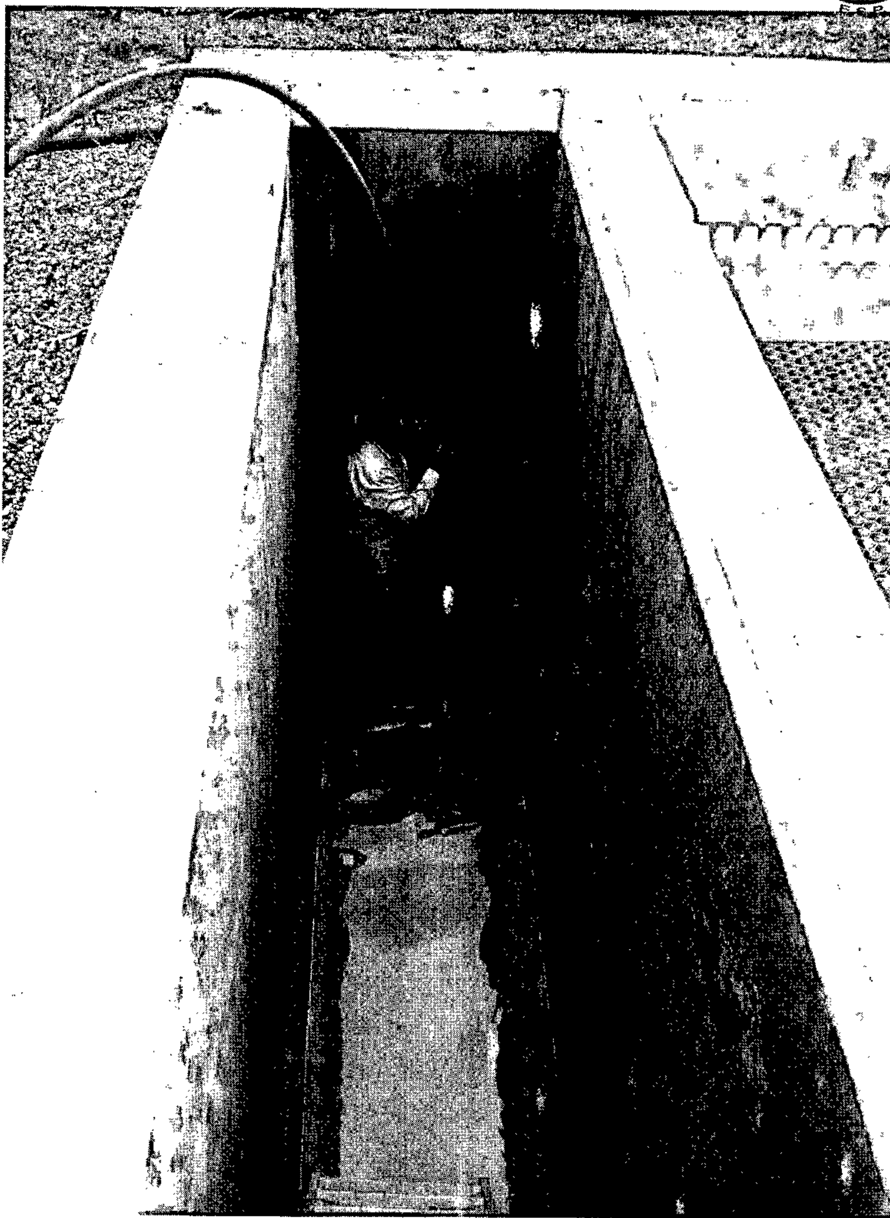
Lavado de un modulo del sedimentador
