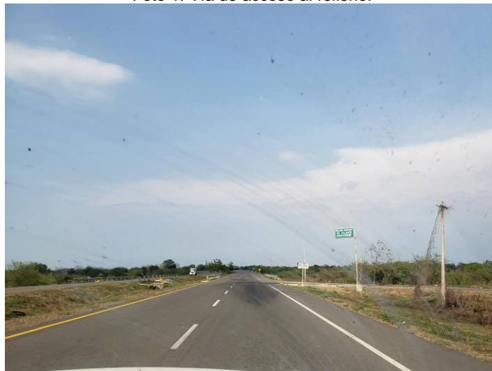
Foto 1. Vía de acceso al relleno.
