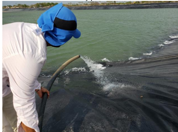
Foto 18. Lixiviado tratado y piscina de almacenamiento
