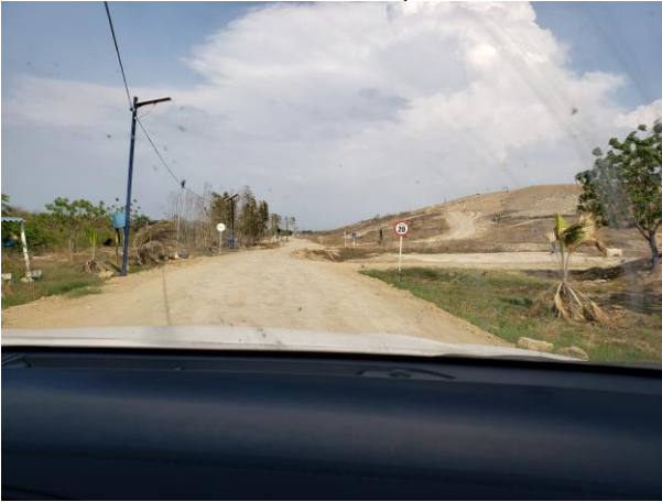
Foto 2. Vía interna parte 1.
