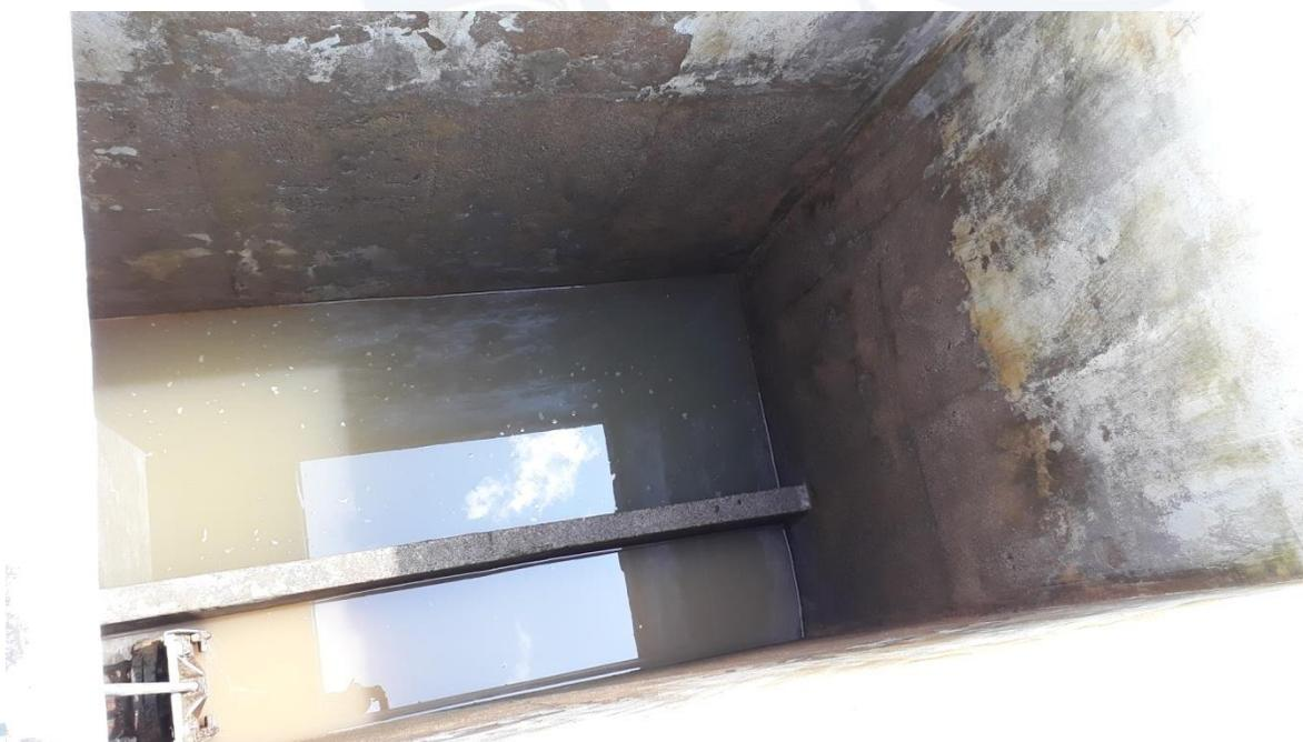
(El agua sucia que queda en los filtros después de restregar las paredes es desechada al momento de lavar los filtros de manera mecánica)
