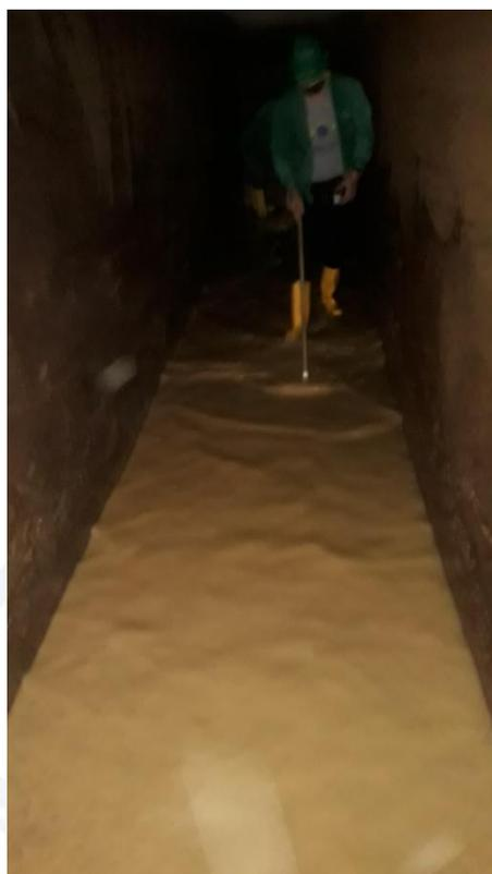
Cuando ya se ha terminado de restregar las paredes y sacar el exceso de agua se inicia el proceso de desinfección.
