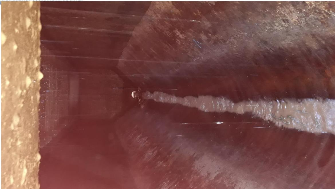
Compartimiento de llegada del agua cruda al inicio del desarenador: aquí se evidencia el estado inicial del compartimiento y el trabajo que se realiza para dejarlos limpios.
