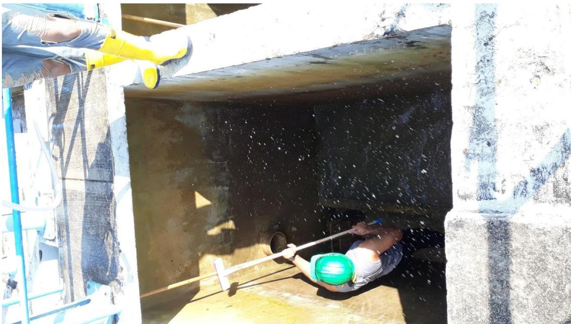
Después de lavar los filtros procedemos al lavado del módulo donde llega el agua filtrada, el procedimiento es igual se ingresa al módulo y se cepillan las paredes, se enjuaga y se procede a sacar el agua que queda con baldes. Al final queda de la siguiente manera.
