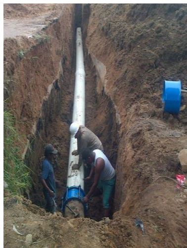
Fotos N° 5 y 6. Control de Fuga y Reposición sobre Tubería 16"
