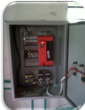
Estación Prado- Entrada- Gabinete de Control
