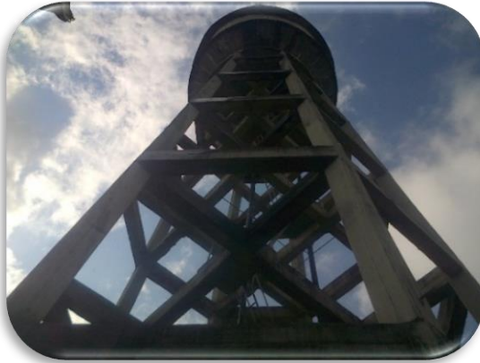
Pruebas de llenado Tanque Zona 1 con 40 l/s
