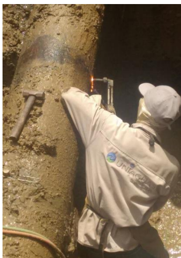
Fotos N° 5 y 6. Control de Fuga y Reposición sobre Tubería 16"
