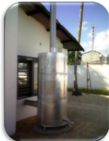
Estación Venus- Entrada- Sistema de Control de olores
