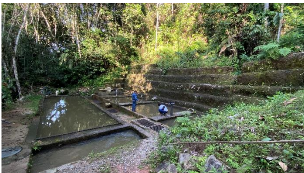
Muros de contención en los desarenadores
