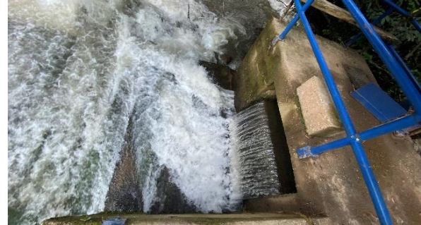
Vertedero de excesos en la bocatoma
