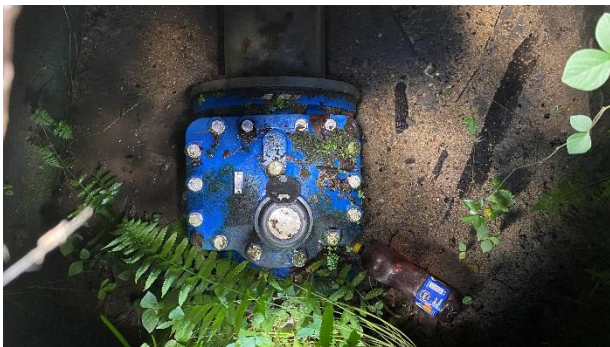
Macromedidor principal de línea de salida 10"
