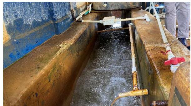
Dosificación en resalto hidraulico
