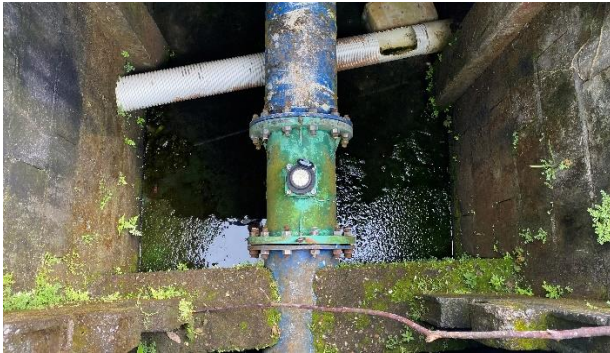
Macromedidor salida Tanque de respaldo
