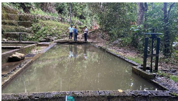
Desarenador (Año construcción 1988)
