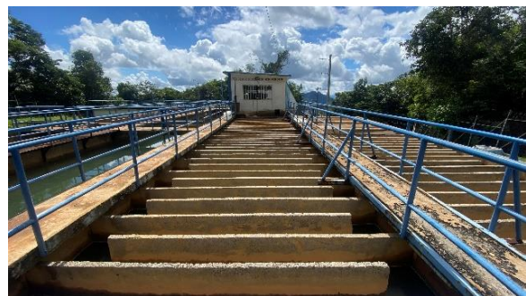
Segunda línea de floculación
