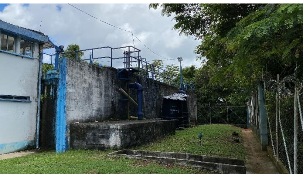
Tanque principal de compensación y balance de caudales
