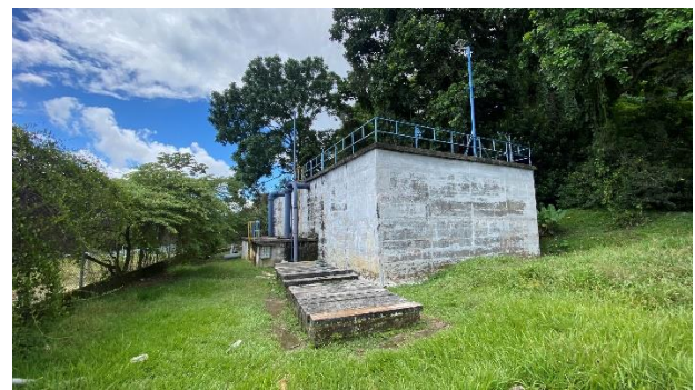
Tanque secundario de compensación y balance de caudales
