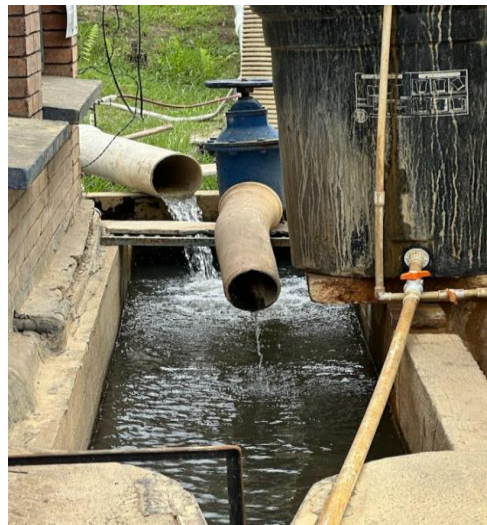
Canal de ingreso caudal río Une y caudal adicional
