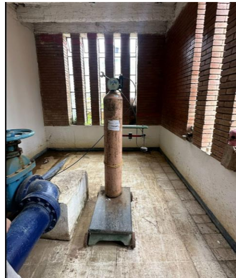
Dosificación Cloro gaseoso
