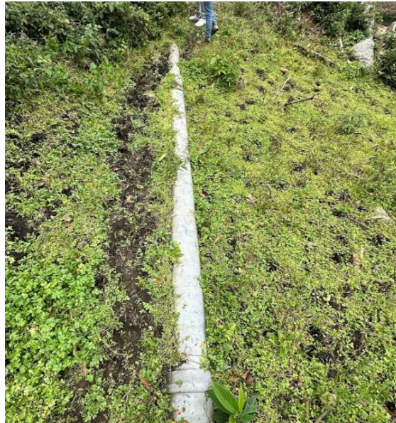
Tramo aducción descubierto
