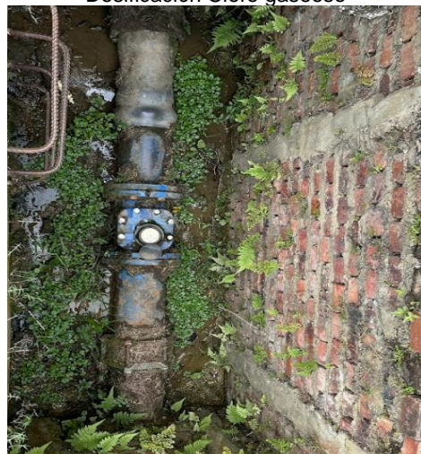
Macromedidor salida 2
