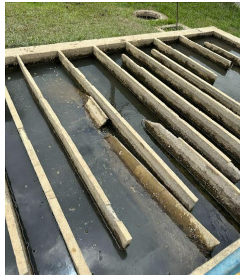
Daños en placas del floculador
