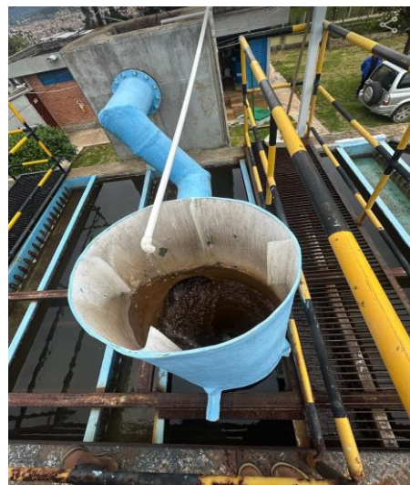
Hidro Ciclón – Mezcla Rápida
