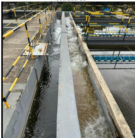
Canal de agua sedimentada
