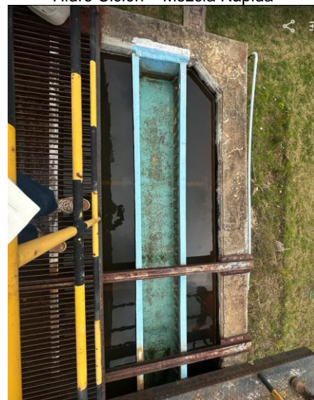
Canal de aquietamiento
