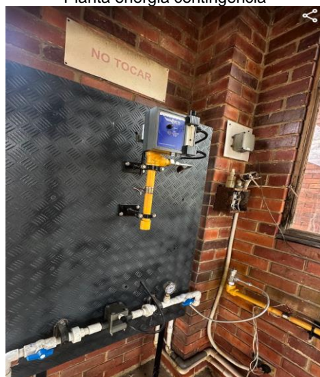
Sistema dosificación cloro
