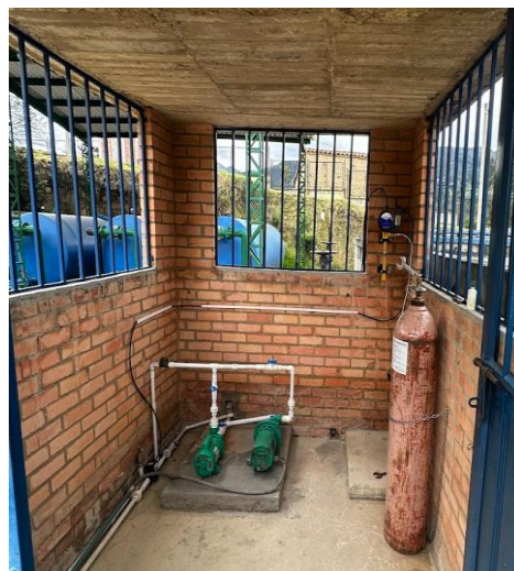
Disifcadores y almacenamiento de cloro gaseoso
