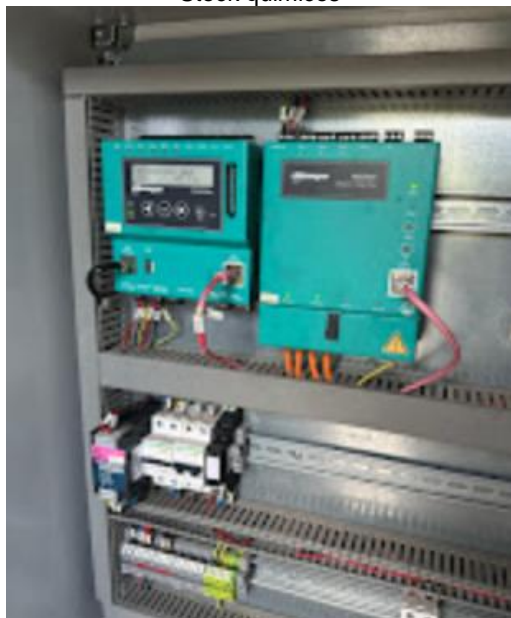
Macromedidor salida (No operativo)
