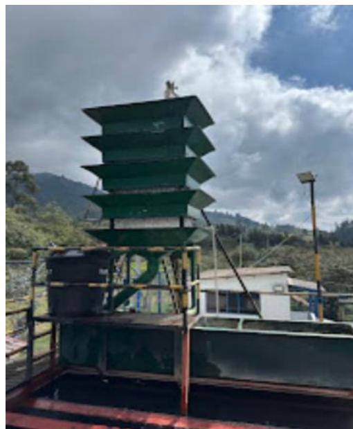
Bandejas de aireación
