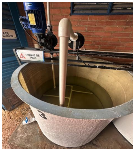
Tanque preparación y dosificación Soda
