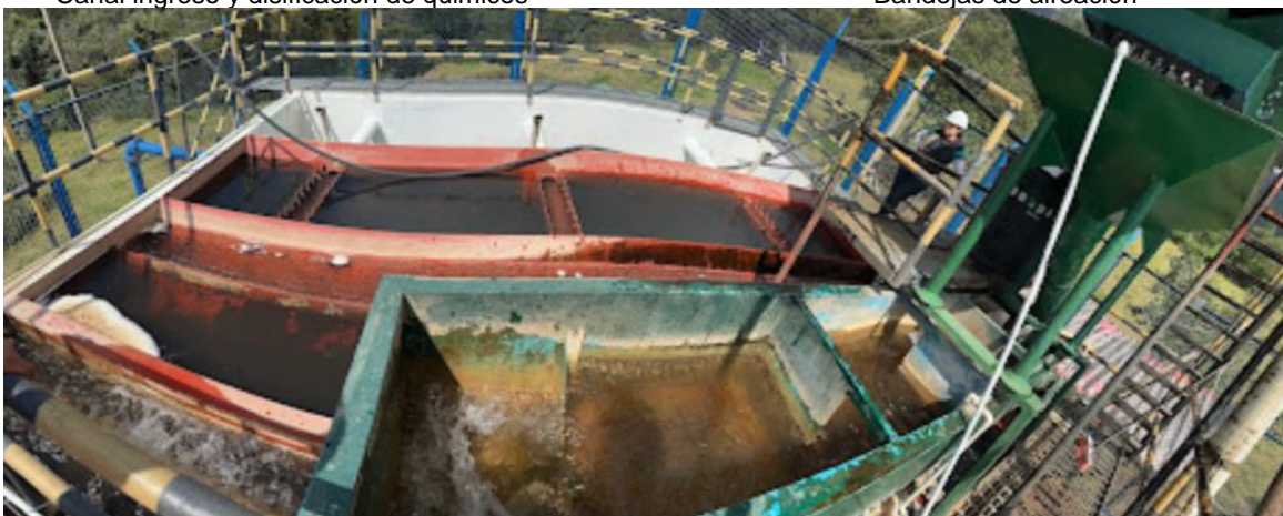
Floculador y sedimentador
