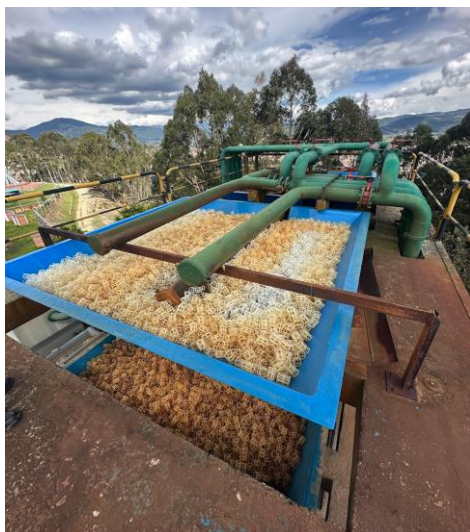
Vista superior bandeja de aireación
