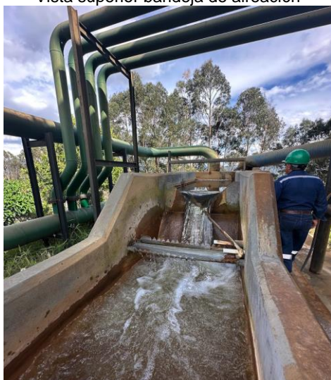
Canal de entrada a la PTAP – resalto hidraulico
