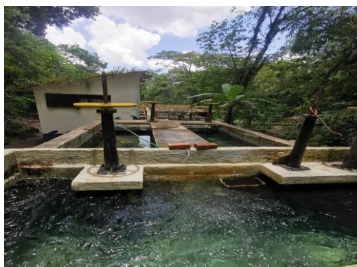
Tanque y canal de entrada – Canaleta Parshall
