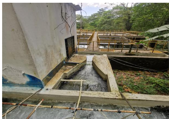
Tanque y canal de entrada – Canaleta Parshall
