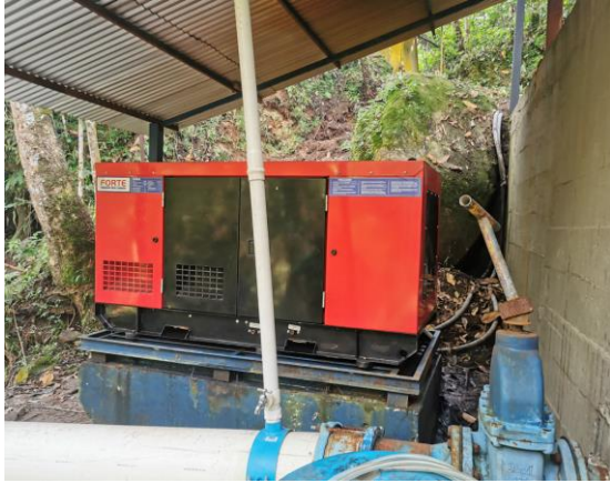
Planta de energía alterna y tubería de salida Fuente: Visita SSPD – EAAV E.S.P
