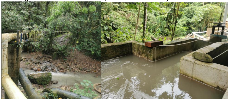
Imagen 21. Fuente caño blanco, tubería de aducción y canal de entrada
