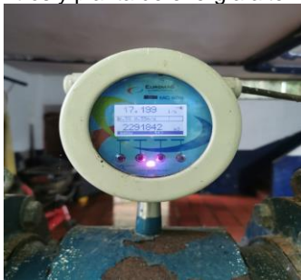
Macromedidor entrada a PTAP Fuente: Visita SSPD – EAAV E.S.P
