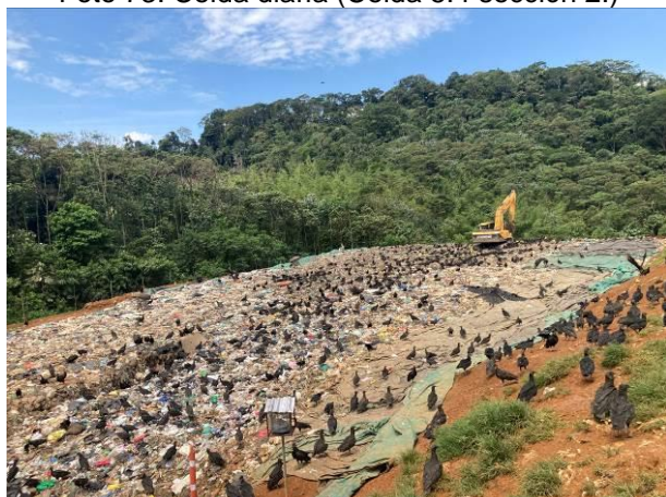
Foto 73. Celda diaria (Celda 5.4 sección 2.)
