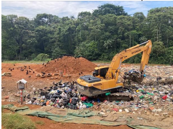
Foto 77. Retroexcavadora haciendo compactación
