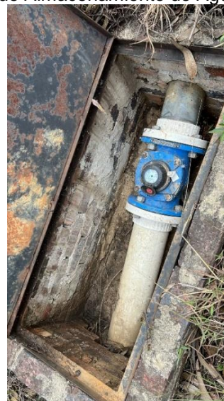
Macromedidor de salida de la PTAP
