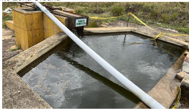
Tanque de Sedimentación
