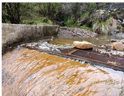
Imagen 7 Captación y desarenador de la USP DG.
