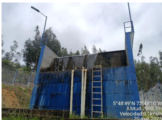
Rebose de agua en los filtros colmatados.
