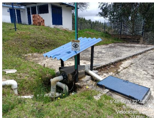
Sistema de luz ultravioleta fuera de operación
