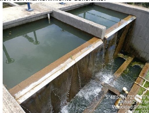
Unidades de sedimentación colmatadas y rebose de agua por sus estructuras.
