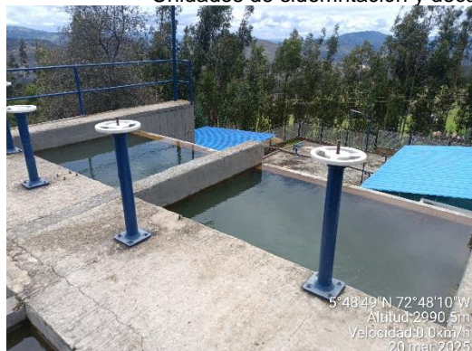
Unidades de sedimentación colmatadas y rebose de agua por sus estructuras.
