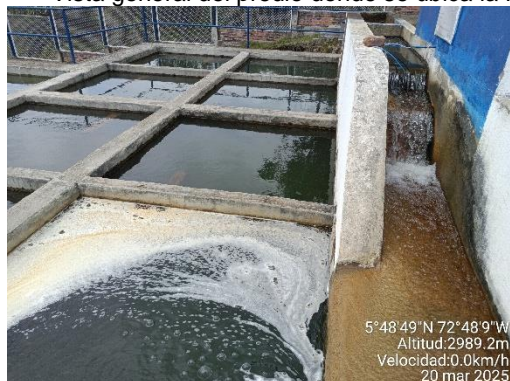
Canal de acceso de agua cruda, unidades de floculación, preparación de productos químicos
