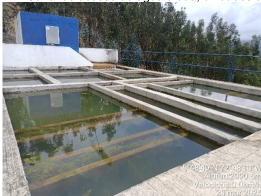
Unidades de sidemntación y decantación con mantenimiento deficiente.
