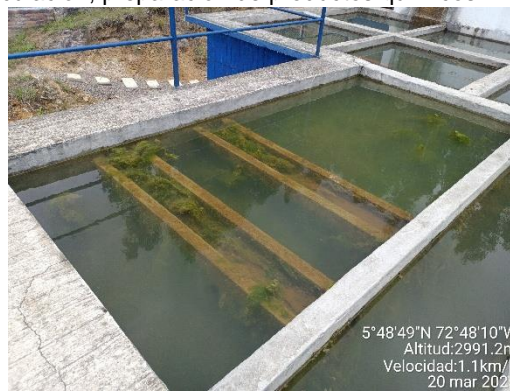
Unidades de sidemntación y decantación con mantenimiento deficiente.
