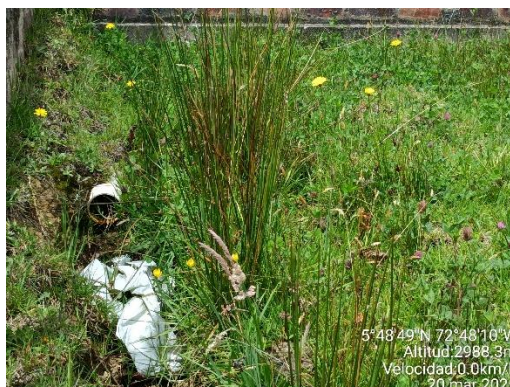
Punto de descarga de aguas de lavado y lodos de las unidades de floculación, sedimentación y filtración de la PTAP de la USP DG
