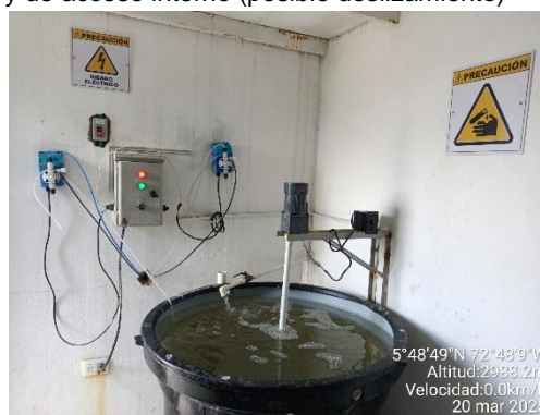
Canal de acceso de agua cruda, unidades de floculación, preparación de productos químicos
