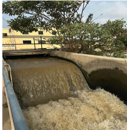
Ingreso con resalto hidráulico
