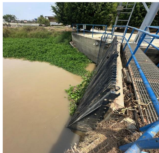
Cribado con limpieza automática
