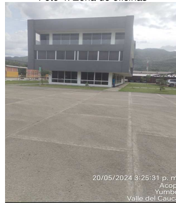
Foto 4. Zona de oficinas
