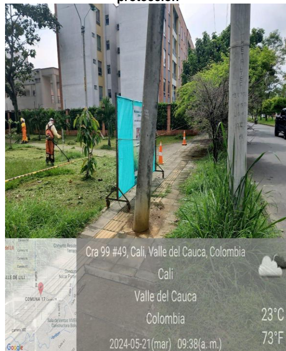
Foto 47. Corte con demarcación y malla de protección
