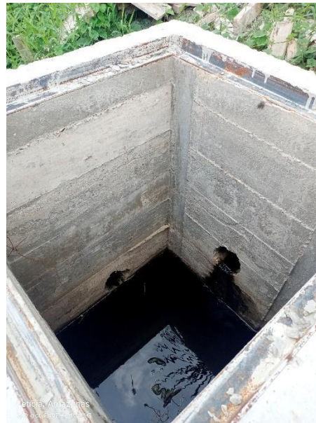
Foto 95. Pozo de inspección del sistema de tratamiento de lixiviados sin entregar y con lixiviados
