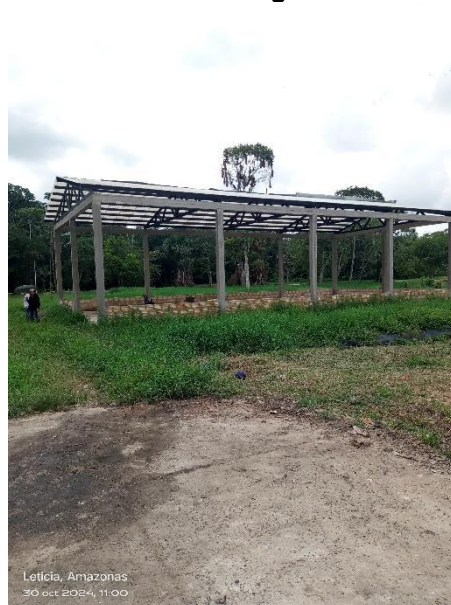
Foto 97. Lecho de secado de lodos del proyecto sin entregar
