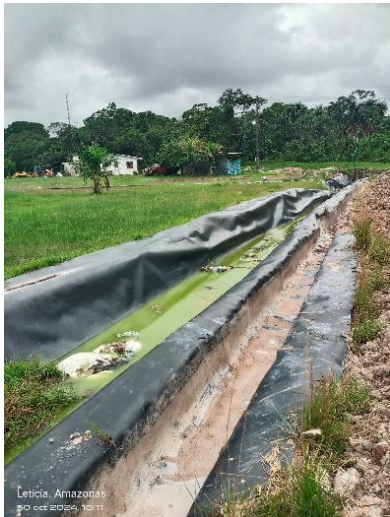
Foto 88. Sistema de canales de lixiviados
