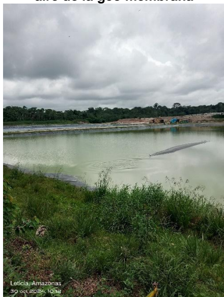
Foto 92. Piscina de lixiviados # 1 filtración de aire de la geo membrana
