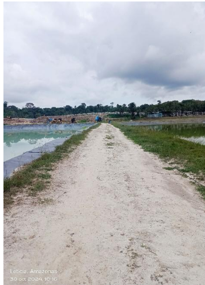
Foto 91. Tren de piscinas para almacenamiento de lixiviados
