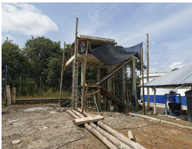
Torre de aireación en construcción
