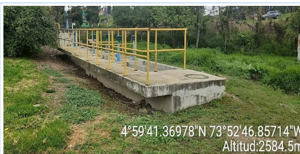
Ilustración 2 Cámara de entrada y cribado
