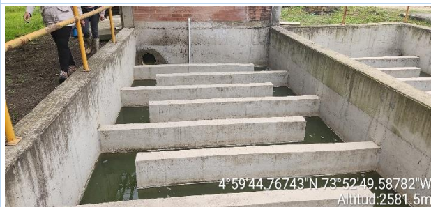
Ilustración 8 Tanque de contacto
