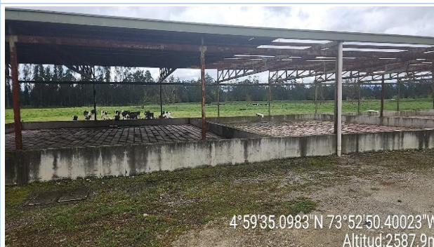
Ilustración 6 Lechos de secado
