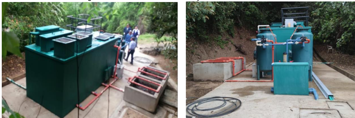
Imagen 4. Tratamiento Secundario y Terciario PTAR Alicante
