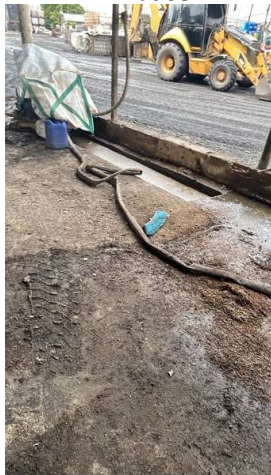
Foto 32 Canaleta de descargue y bombeo de lixiviados
