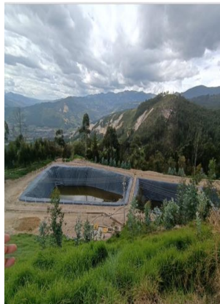
Pondajes de lixiviados.
