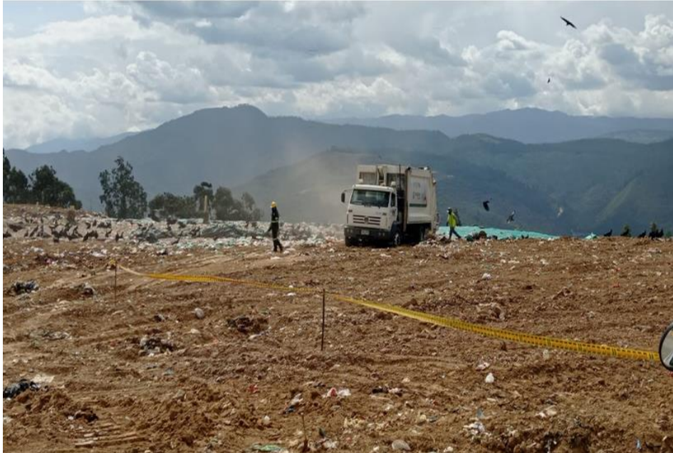
Frente de trabajo vaso C.
