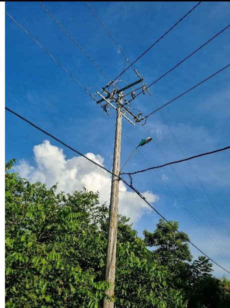
8°54'44.6"N 75°50'41.6"W Estructura terminal cable AAAC 4/0 -1.100 metros e inicio cable ecológico.
