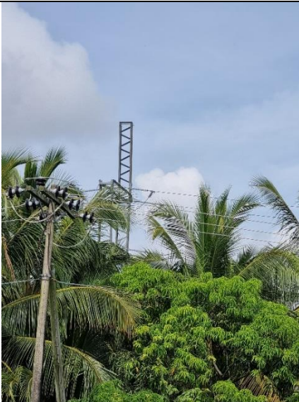
Estructura No 190 final tramo1 reconducción AAAC 246,9
