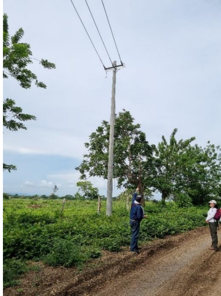
Estructura terminal, cable CF63, aproximadamente 7,8 KLM
