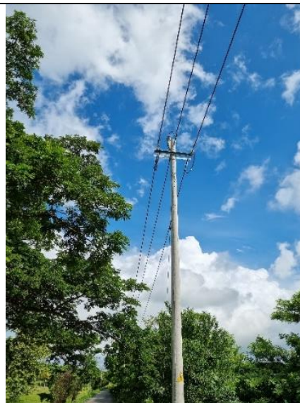
08°58'33.13"N 76°14'28.97"W, Inicio cable ecológico CF125 configuración sencilla
