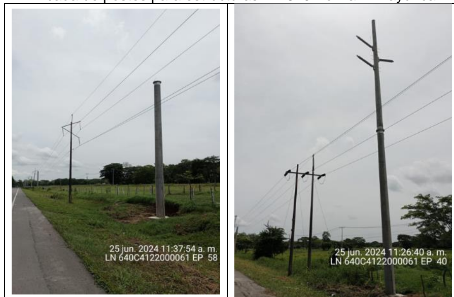
Hincada de postes para estructuras LN 640 Bolívar – Bayunca.
