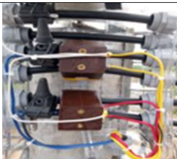
Transformadores de corriente.
