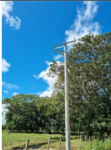
8°43'17.3"N 75°57'11.4"W, Estructura final tramo cable CF125.
