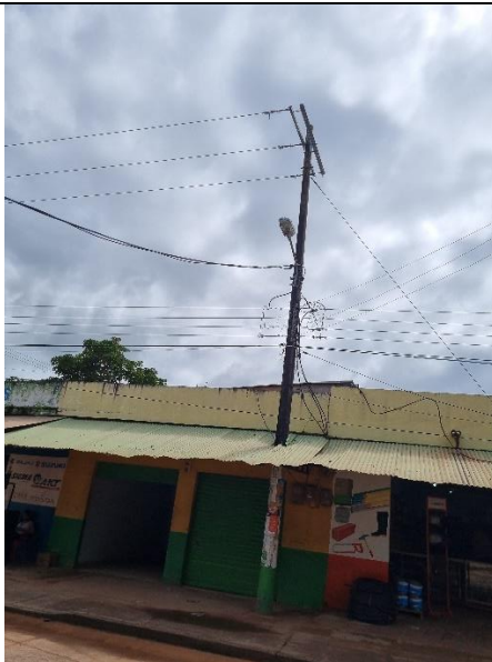
9°08'53.2"N 74°13'32.4"W Estructura inicio tercer tramo cable 1/0 desnudo
